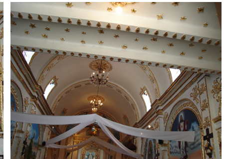
Imagen donde se aprecia el artesanado en yeso y pintura.
