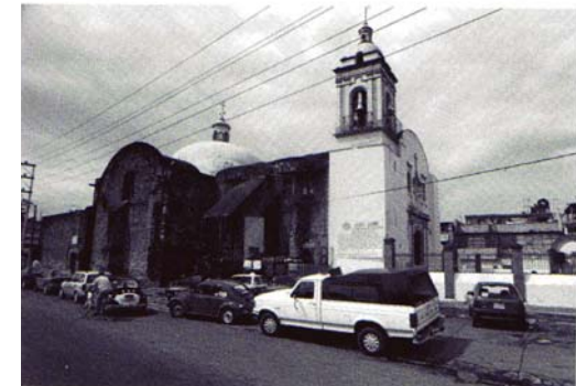
Xaltocan con el canal sustituido por una avenida. A la orilla del agua p. 19
