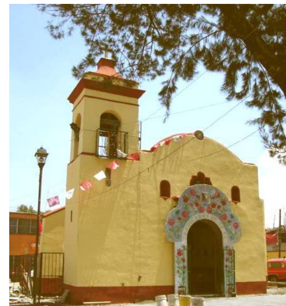
Vista general de la capilla
