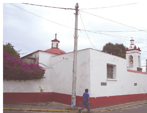
Perspectiva desde la sacristía. Fachada posterior del inmueble
