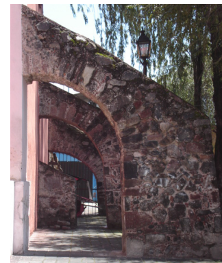
Arco botarel (contrafuerte)
