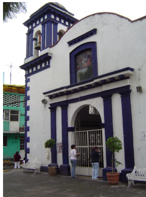
Vista general de la portada
