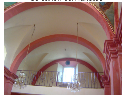
Cubierta en sección y coro alto con bóveda de cañón con lunetos
