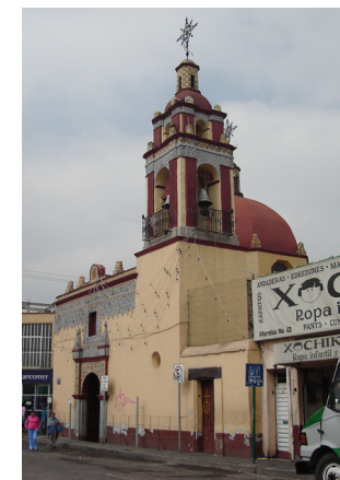
Vista general de la capilla
