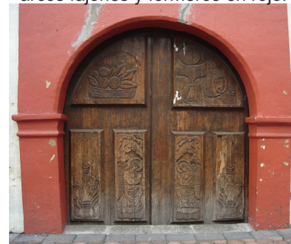
Puerta de fachada de madera tallada
