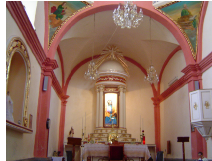
Presbiterio con cubierta de bóveda de cañón con lunetos
