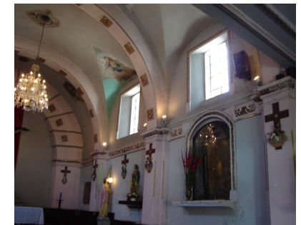
Muro lateral izquierdo
