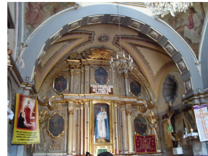
Imagen de presbiterio en donde se aprecia arco fajon, muro testero y cubierta.
