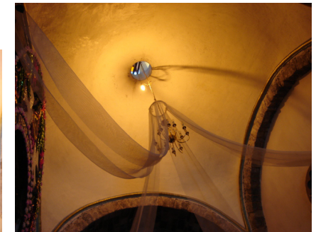
Imagen de la bóveda vaída
