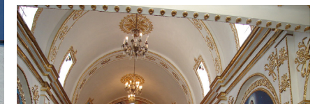
Ornamentación en elementos estructurales.
