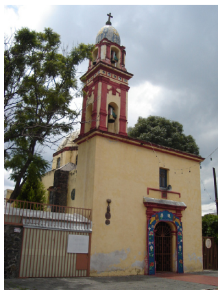
Vista general de la capilla
