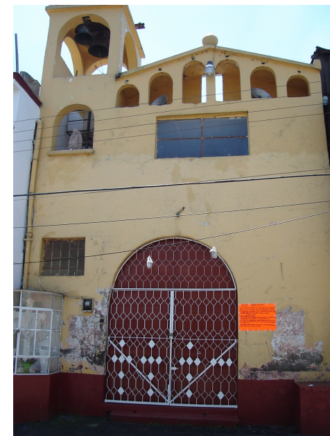
Vista general de la capilla desde calle de Violeta.
