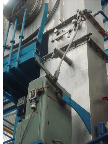
FIGURA 5.3 – ESLABONAMIENTO MECÁNICO
