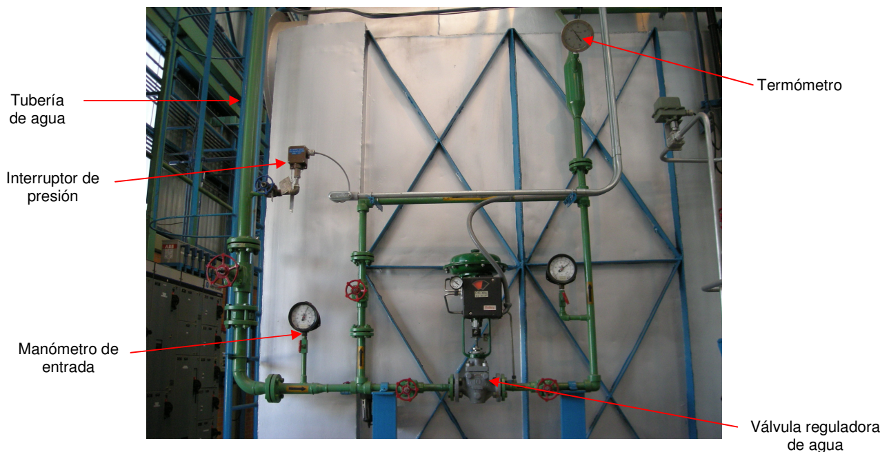
FIGURA 4.2 – ELEMENTOS EN EL CONTROL DE NIVEL
