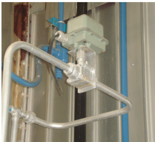
FIGURA 3.3 – VÁLVULA PURGA CONTINUA
