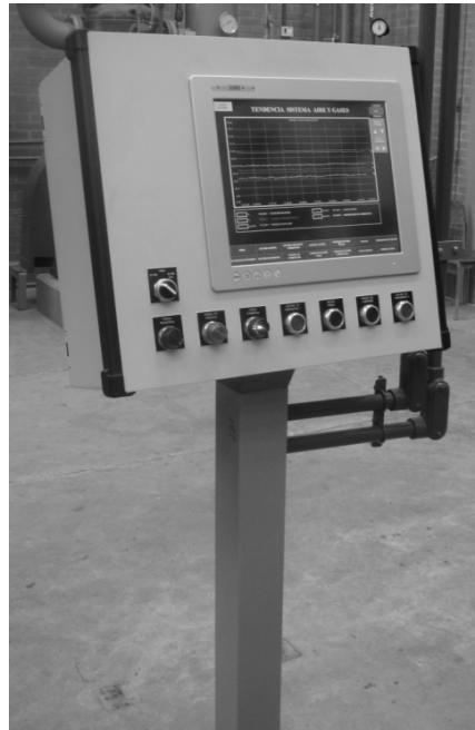
FIGURA 7.5 – ESTACIÓN DEL OPERADOR
