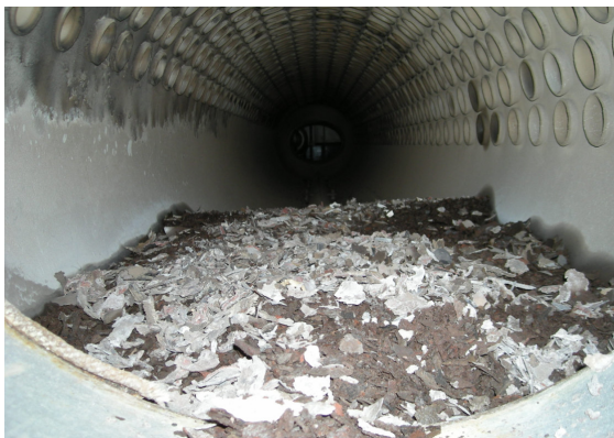
FIGURA 3.1 – ACUMULACIÓN DE SÓLIDOS EN EL DOMO DE LODOS
