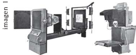
Cámara Klimsch, horizontal y vertical de reproducción.
