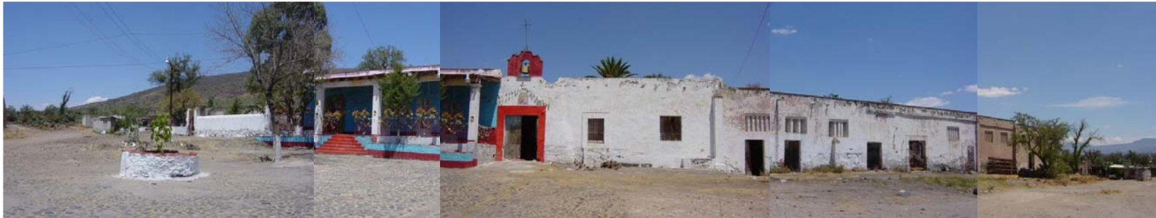
1. VISTA HACIA EL CASCO DESDE EL PATIO EXTERIOR DE LA HACIENDA
