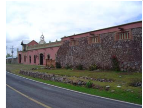
Ilustración 3: Vista de la Fachada de la Hacienda de La Concepción, Pachuca Hidalgo.
