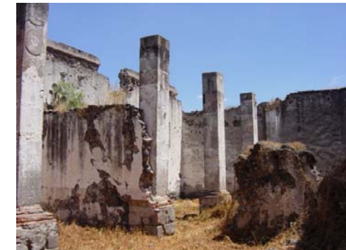
Ilustración 54: Vista de la antigua troje que se intervendrá para crear dos niveles de habitaciones.
