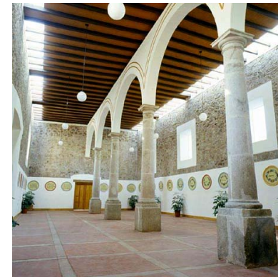
Ilustración 26: Intervención de un antiguo tinacal para convertirlo en un salón de usos múltiples; Hacienda de la Concepción.
