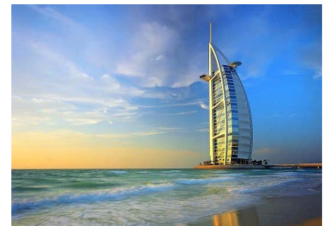
Ilustración 20: Tipo All Suites, Hotel Burj Al Arab, en Dubai EAU
