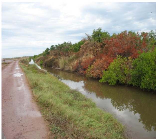
Figura 46. Canal de descarga.
