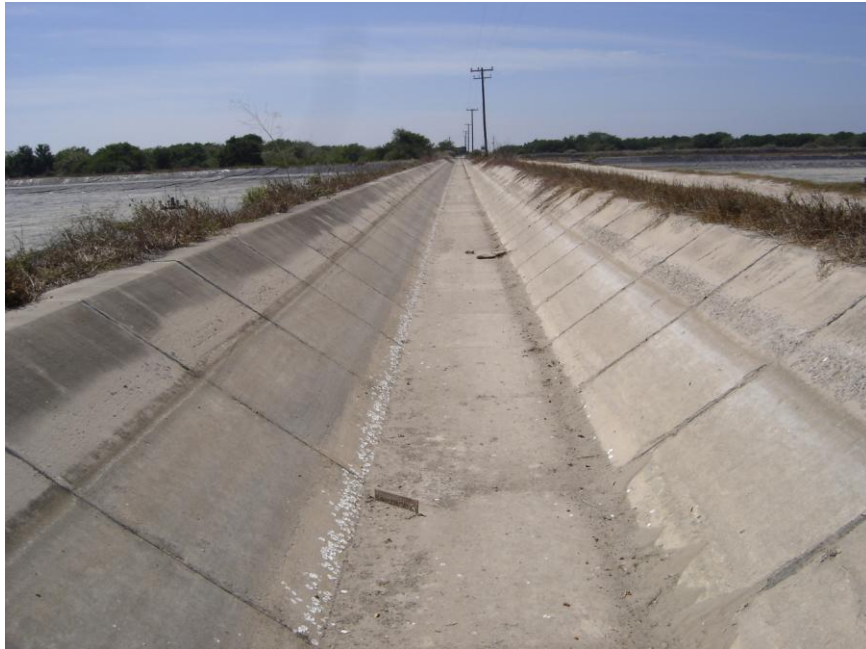
Figura 77. Vista del tramo principal del canal de alimentación.
