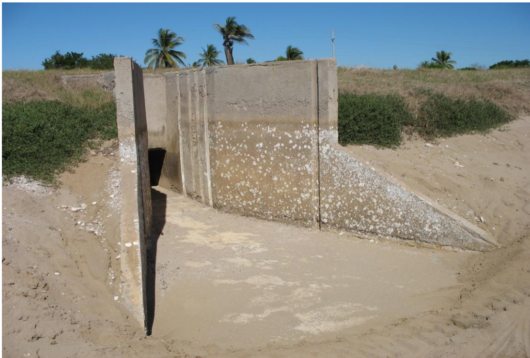
Figura 26. Estructura de salida.
