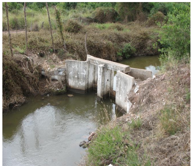
Figura 47. Estructura para el control del agua.
