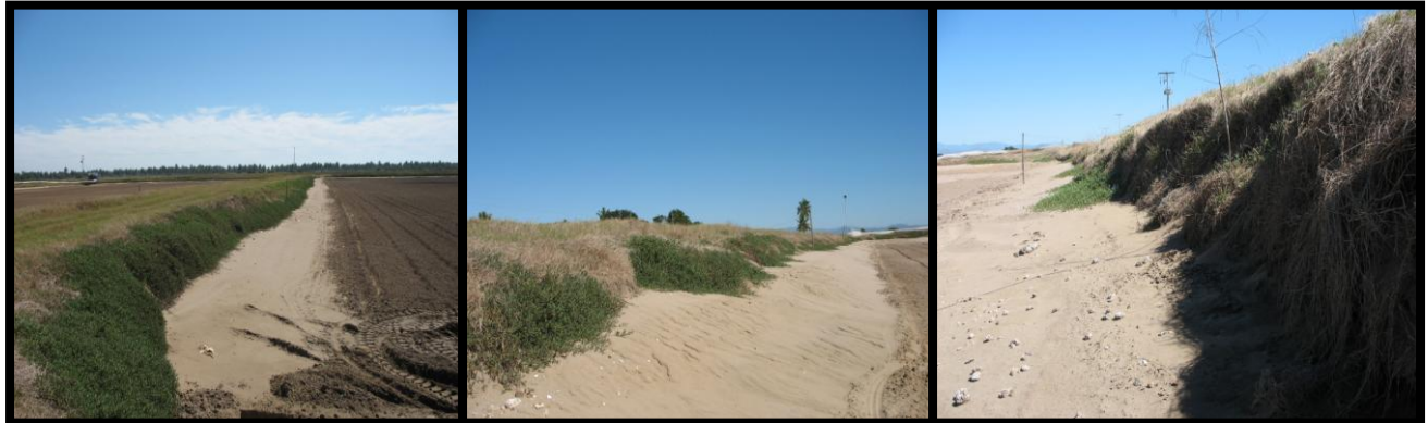
Figura 29. Bordos erosionados.
