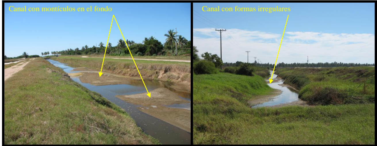
Figura 16. Vistas en diferentes puntos de los canales de descarga.
