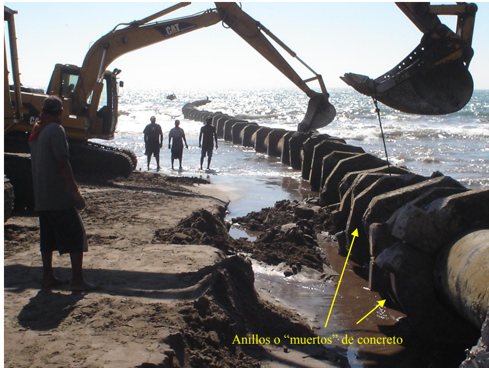
Figura 11. Instalación de la tubería de succión.
