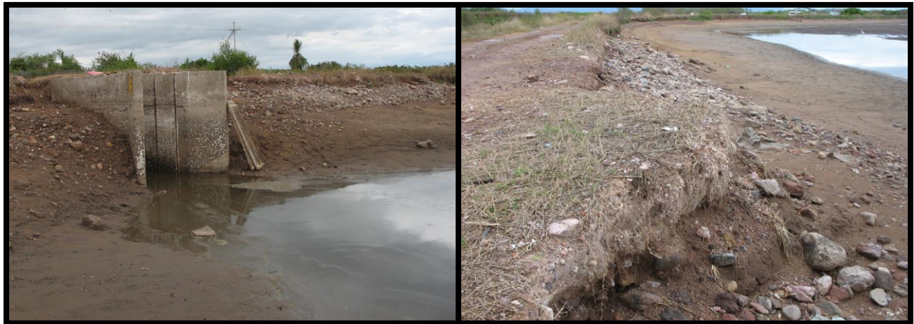
Figura 53. Bordos erosionados.
