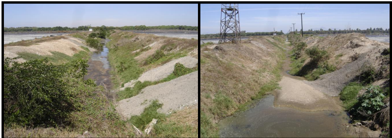
Figura 72. Vistas en diferentes puntos de los canales de descarga.
