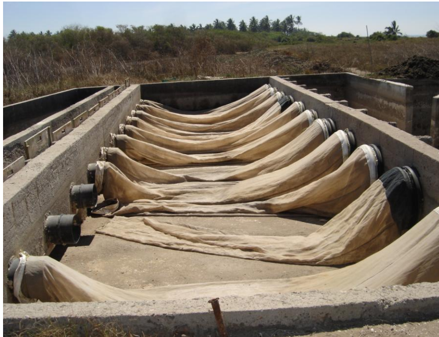
Figura 76. Tercer paso de filtrado mediante los “calcetines”.
