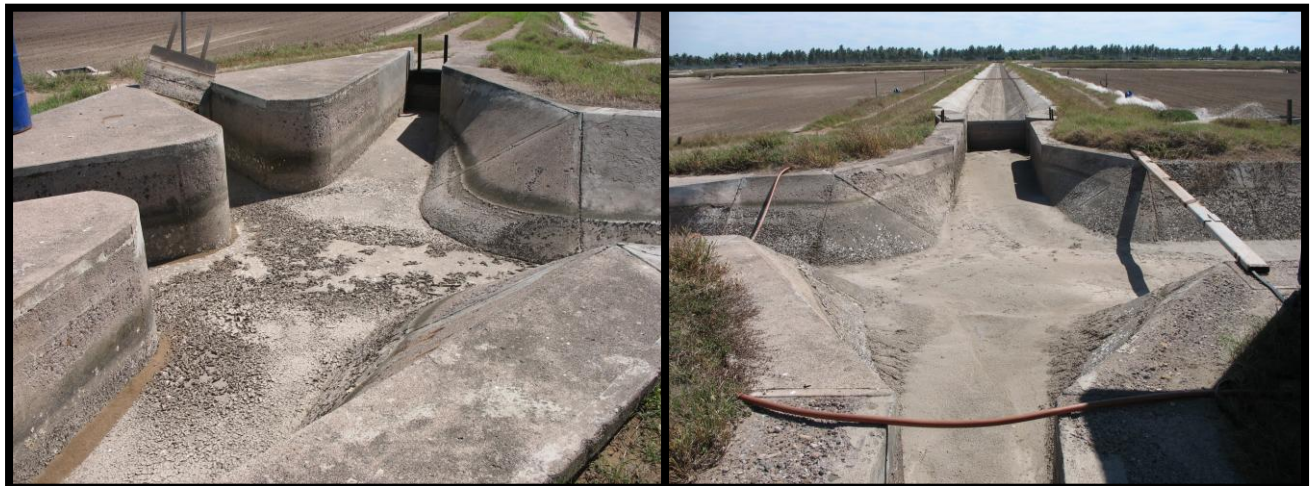
Figura 21. Vistas de los cruceros distribuidores del agua.
