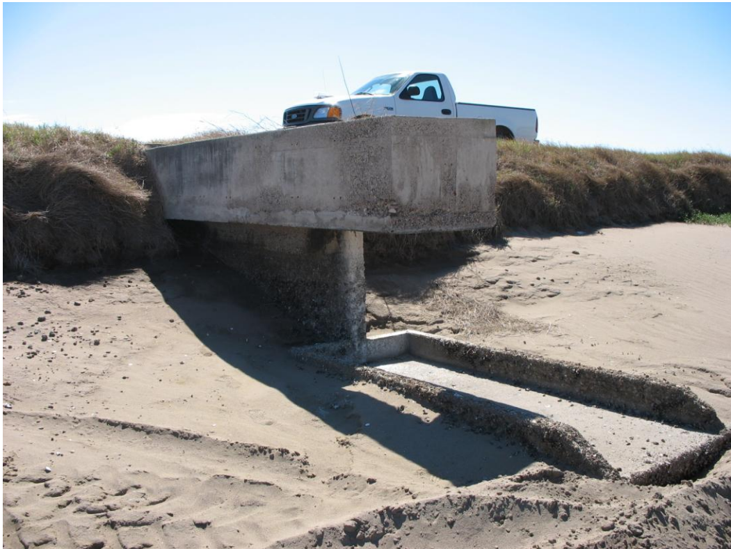
Figura 22. Vista de la estructura de alimentación para los estanques.
