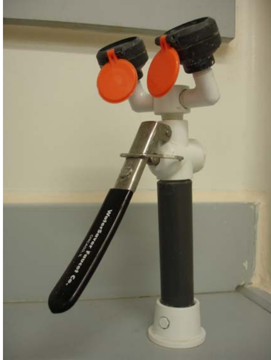
Fotografía 6. Estación de lavado de ojos
