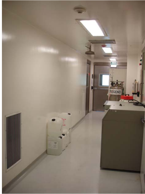
Fotografía 10. Corredor y salida de emergencia.
