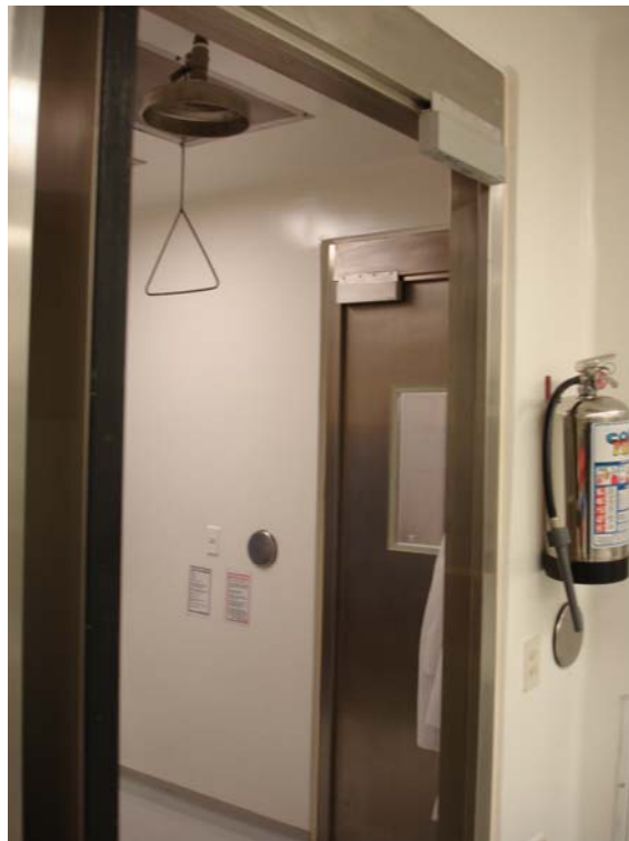
Fotografía 17. Esclusa en el Laboratorios de Bioseguridad Nivel 3.
