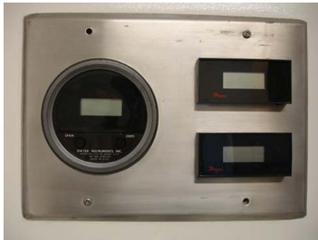
Figura 22. Manómetro digital. BSL3
