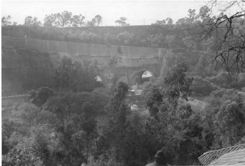
Cruce de la Autopista con la carretera. (Tomada en la desviación hacia Lomas de Vista Hermosa)
