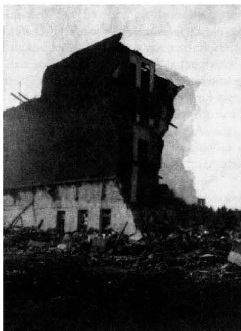
Demoliciones en la avenida Icaria. Martí Llorens
