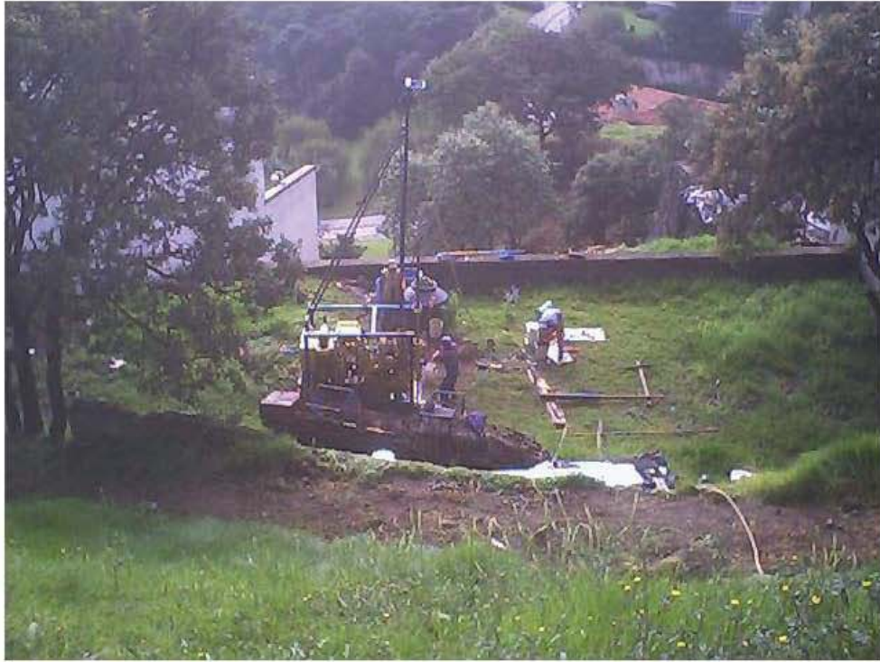
Foto 1: Panorámica del predio
