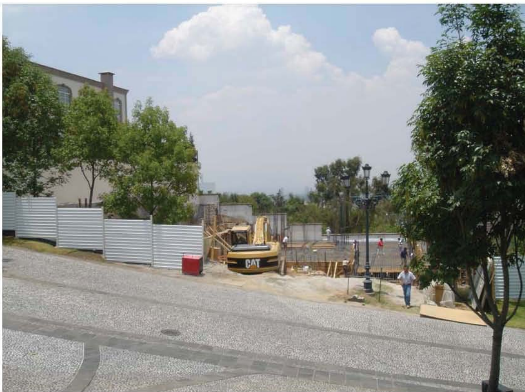
FOTO 22. TRABAJOS DE ESTRUCTURA.
