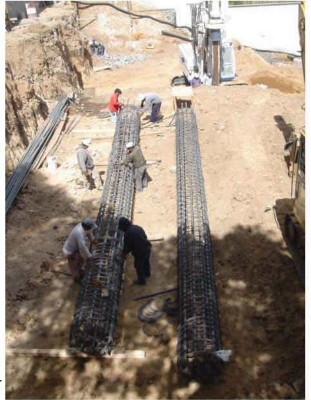
FOTO 19. ARMADO DE PILAS.
