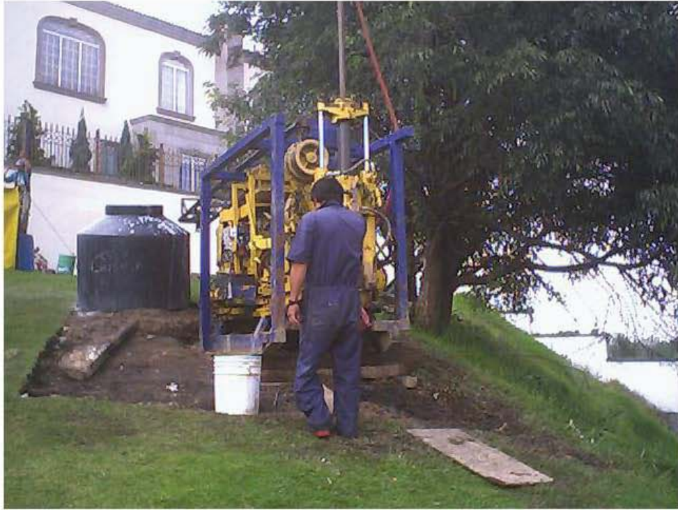
Foto 3: Ejecución del SPT-1
