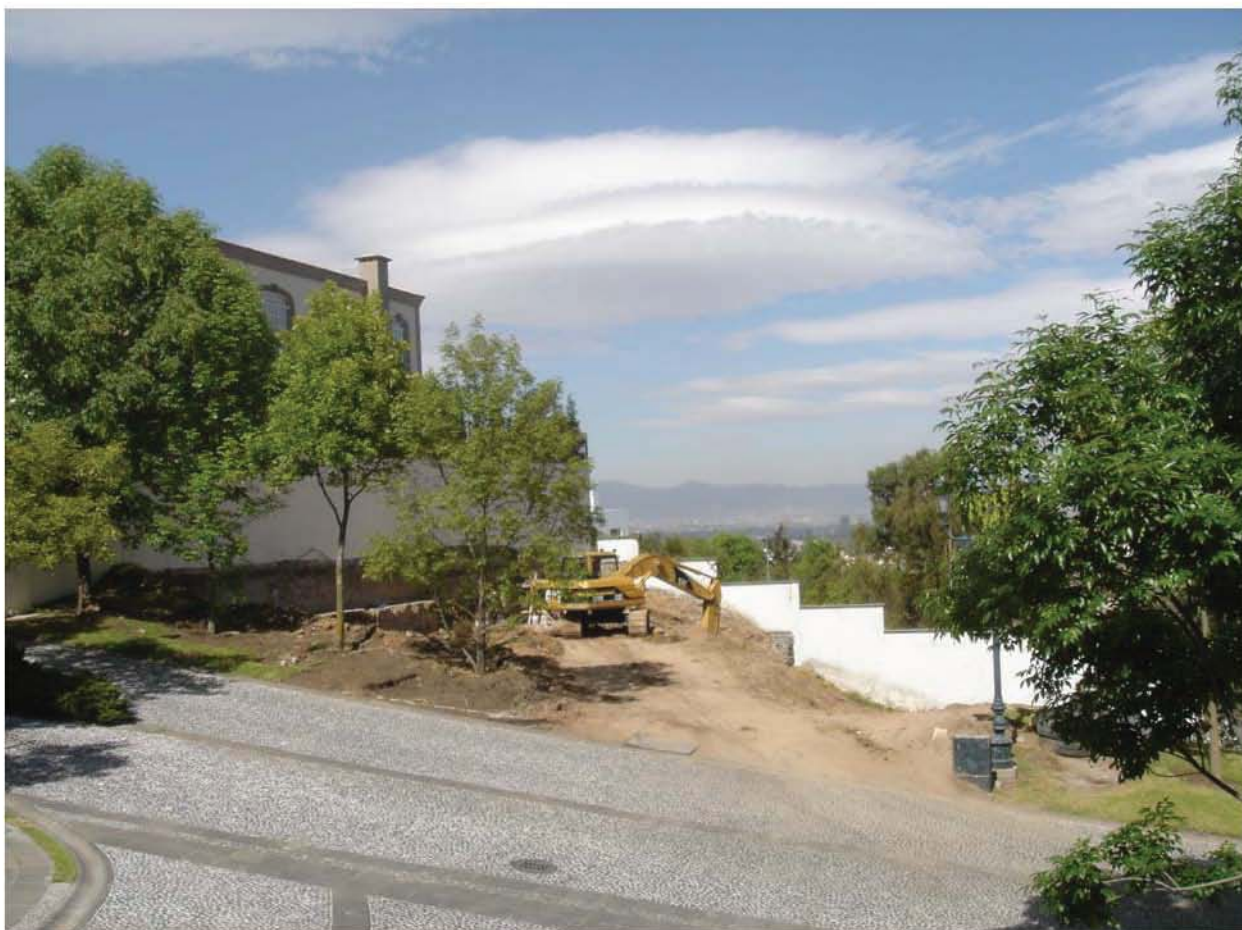
FOTO 18. PREPARACIÓN DEL TERRENO.
