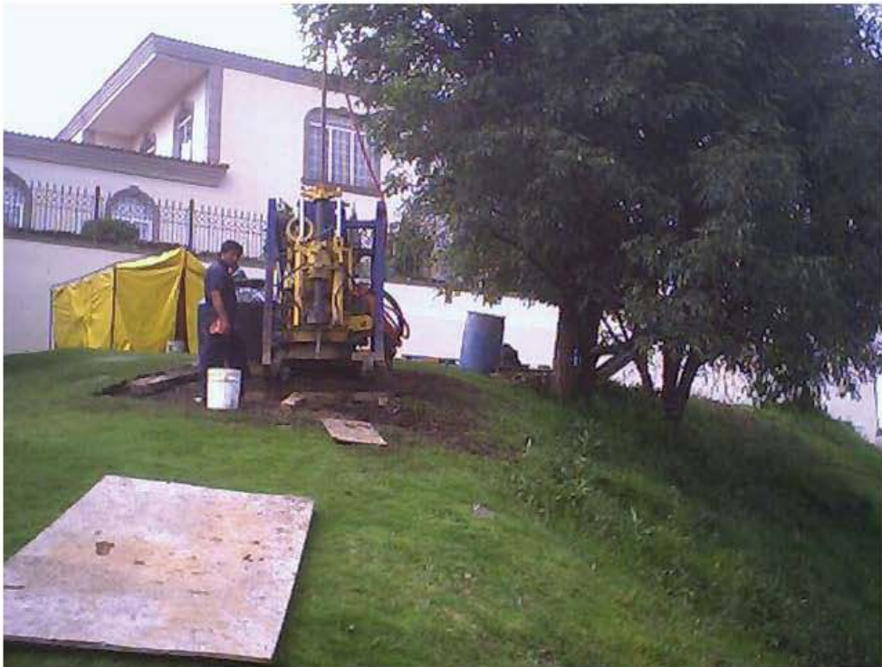
Foto 2: Ejecución del sondeo de penetración estándar 2 (SPT-2)
