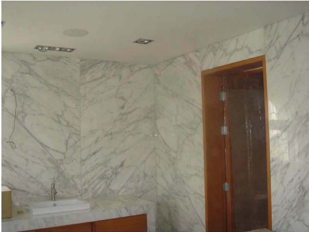
FOTO 29. MÁRMOL ESTATUARIO EN BAÑO SR.
