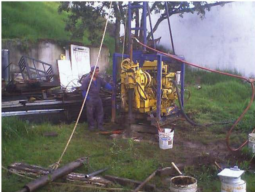
Foto 4: Ejecución del SPT-3
