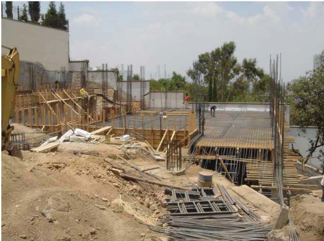
FOTO 21. ARMADO DE LOSAS.
