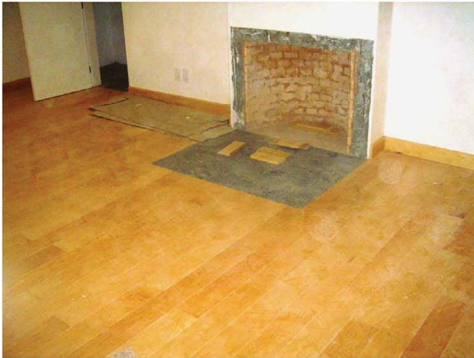
FOTO 31. PISO DE MADERA EN TAPANCO.
