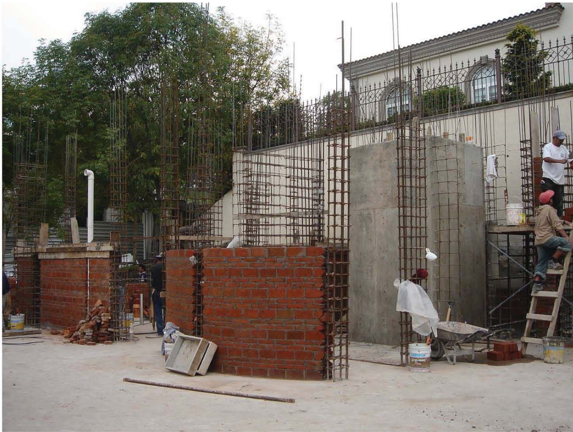
FOTO 23. ALBAÑILERÍAS SEGUNDO NIVEL.
