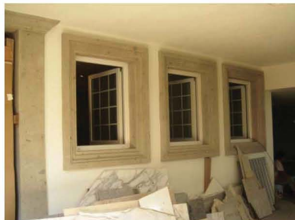
FOTO 45. VENTANAS EN BAÑO DE GIMNASIO.
