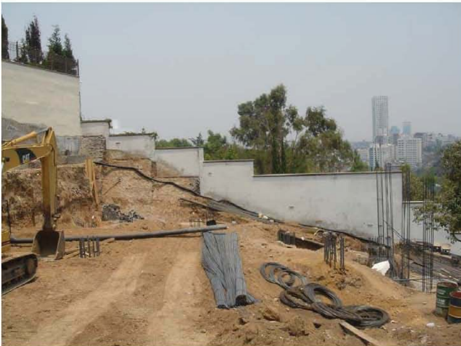
FOTO 20. TRABAJOS DE CIMENTACIÓN.
