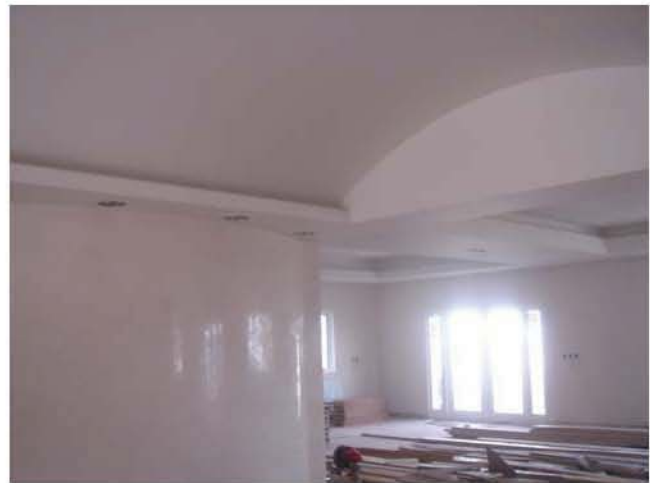
FOTO 33. PLAFONES EN VESTÍBULO.
