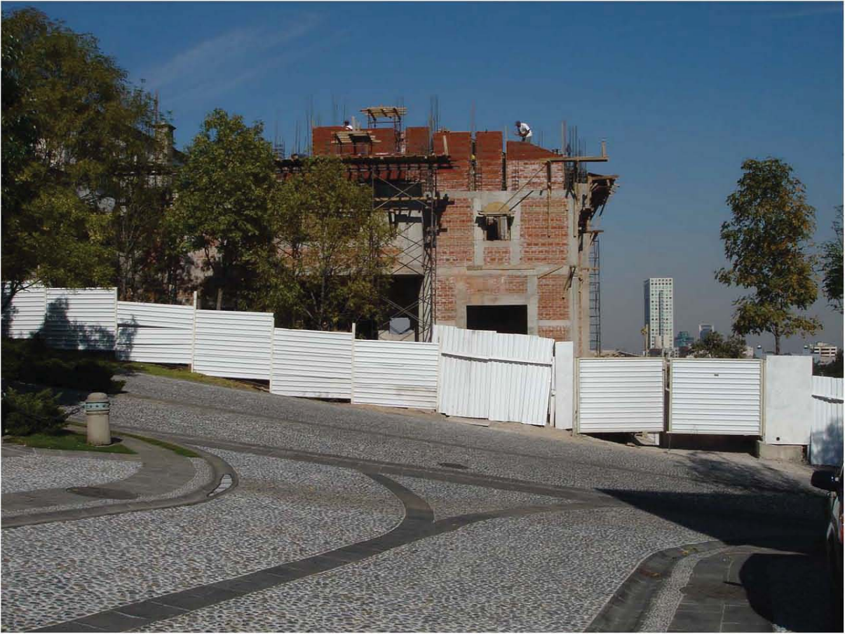
FOTO 24 TRABAJOS DE ALBAÑILERÍAS.
