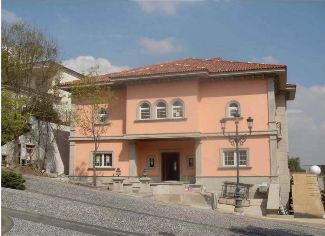
FOTO 37. CANTERAS EN FACHADA PRINCIPAL.
