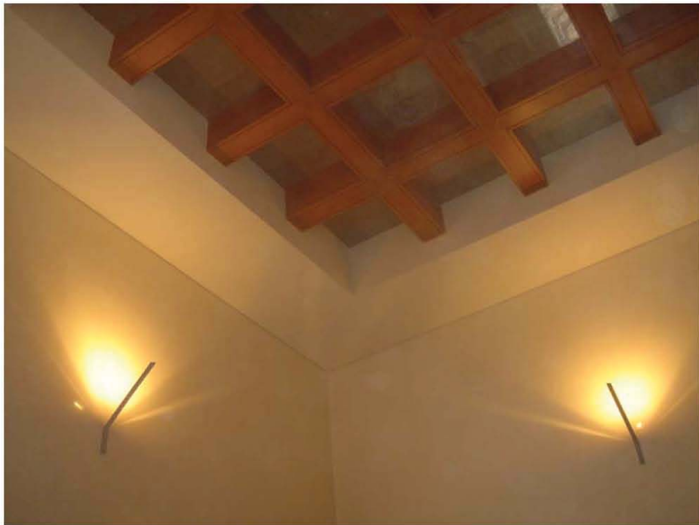
FOTO 35. PLAFON SALA DE ESTAR TERCER NIVEL.
