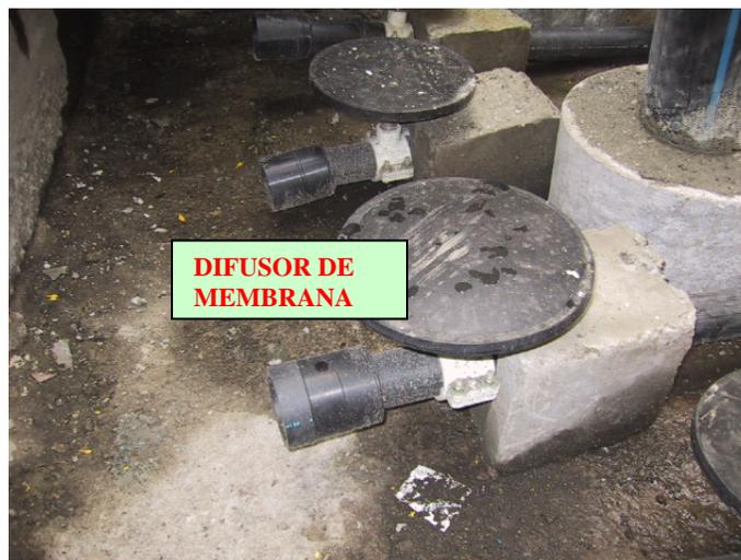
*Figura 4.19 Tubería de polietileno con sus difusores*
