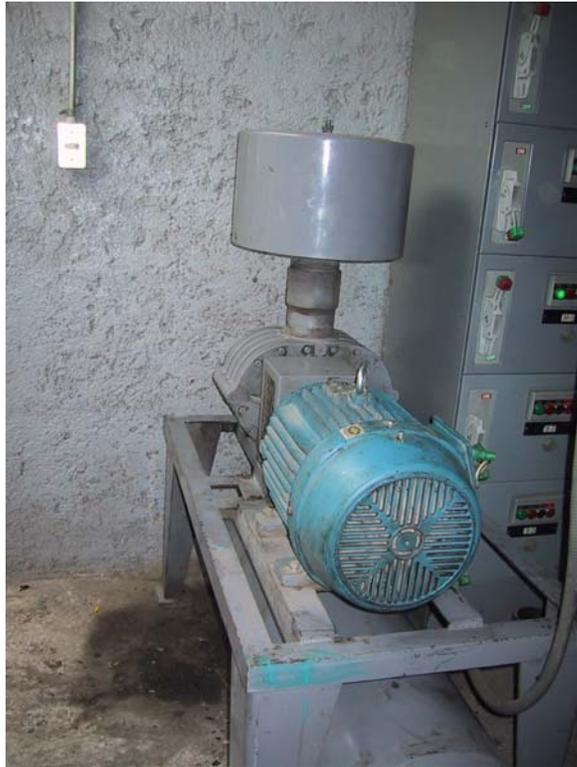
*Figura 2.14 Soplador de lóbulo rotativo*
