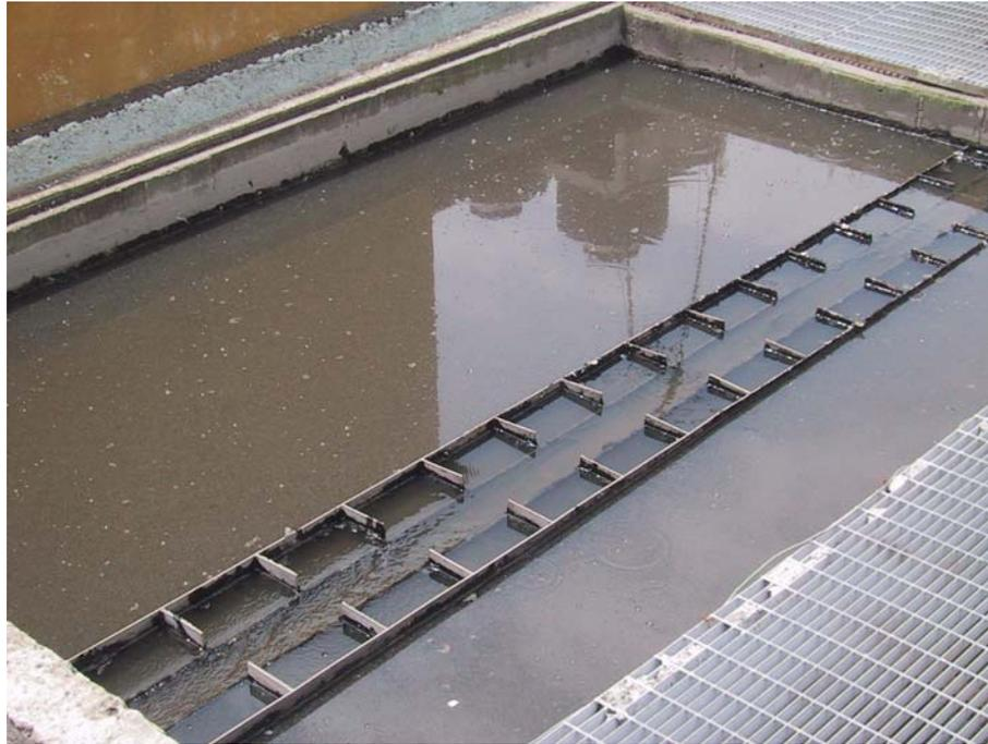
*Figura 4.4 Vista del sedimentador secundario mostrando el desnatador propuesto ya instalado*
