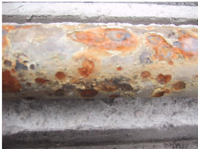
*Figura 4.16 Tubería acero oxidada por la generación de ácidos en los lodos de las aguas*
