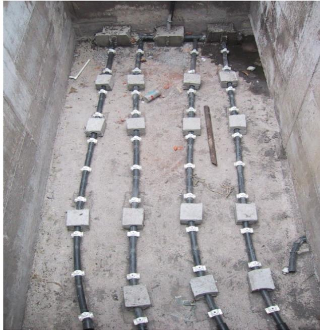
*Figura 4.18 Tubería de polietileno con sus abrazaderas para colocar los difusores*
