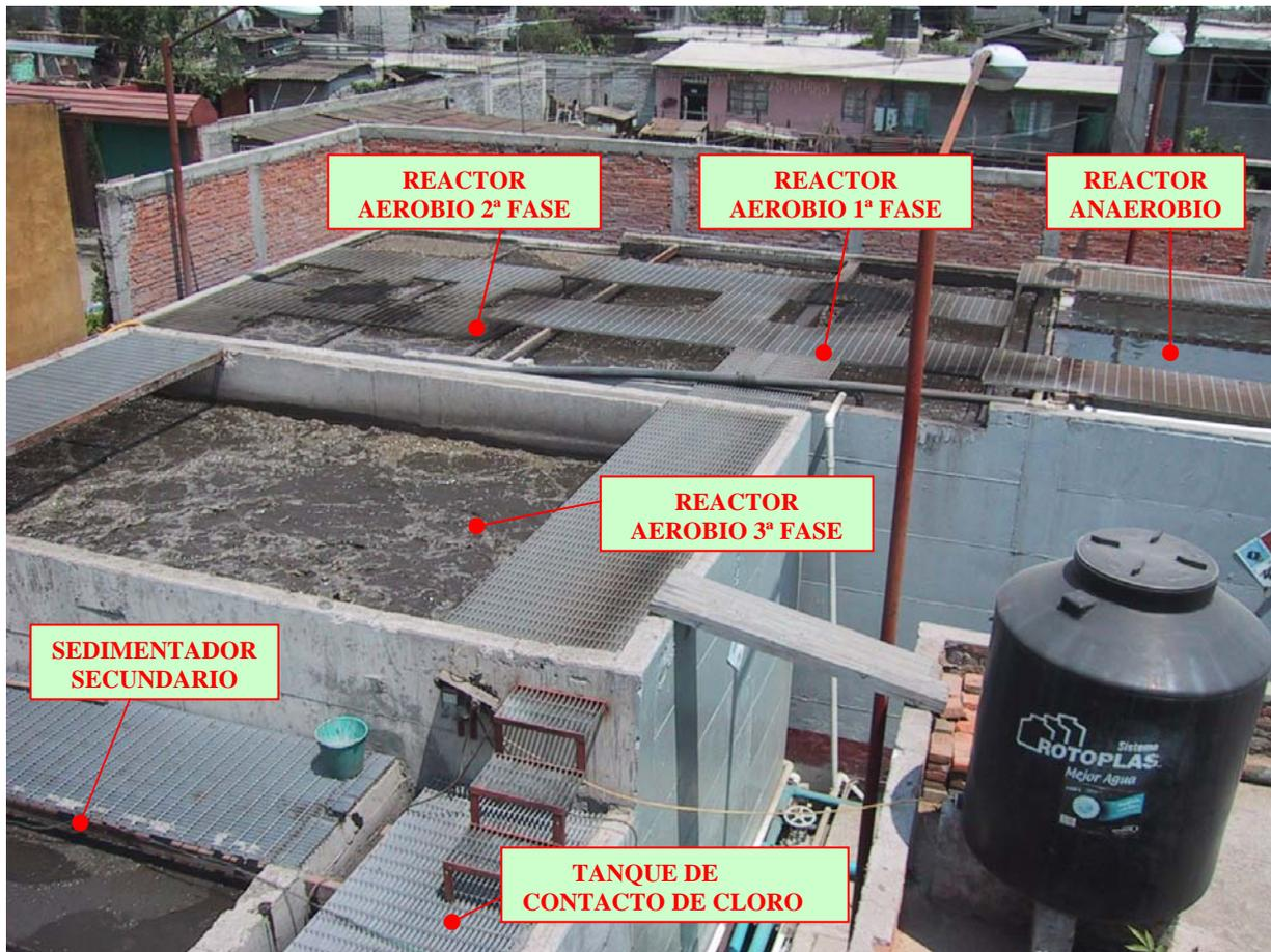
*Figura 4.5 Vista de la planta que muestra tanque de contacto de cloro y deposito de cloro.*
