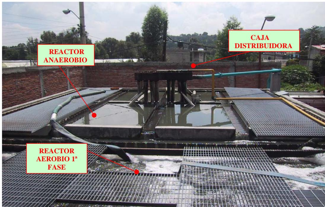
*Figura 2.12 Vertedores para el efluente del reactor anaerobio*
