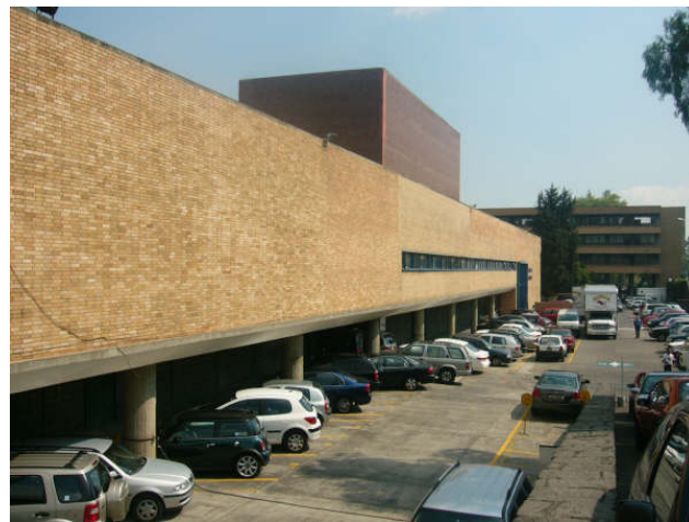
: Vista fachada posterior
