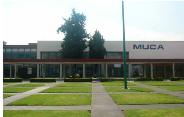
: Vista acceso principal
