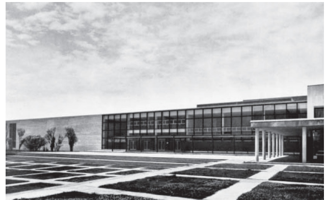
: Vista acceso principal
