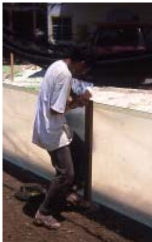
Fig.9 Construcción de tolvera
