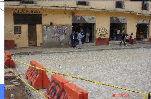
ESTADO ACTUAL DE SAN ANGEL
