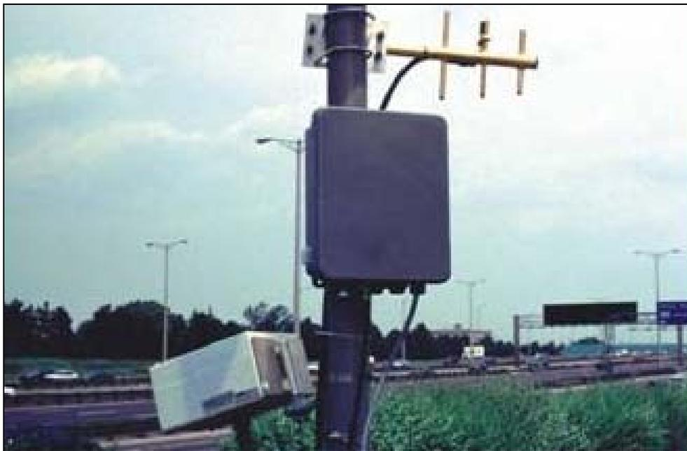
**Figura 5.9 Sensor remoto de tráfico por microondas RTMS**
