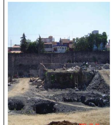
El tipo de cimentación que definió el estructurista para estos edificios fue el de zapatas aisladas, y la condición de mecánica de suelos fue de la encontrar la capa de basalto firme para el desplante de cada una de ellas. Una vez conocidos el diseño estructural y las condicionantes de mecánica de suelo se definió el procedimiento constructivo el cual de manera secuencial se describe a continuación:
