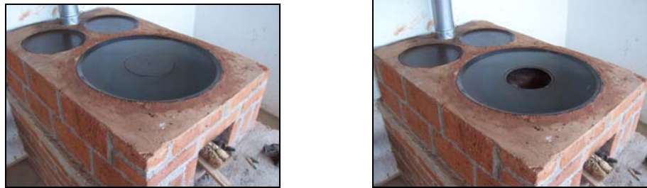
Figura 18. Detalle de la modificación realizada al comal principal
