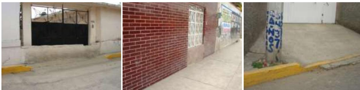
Figuras 4.44 En esta colonia se observa que las adecuaciones que ha hecho la población para evitar la entrada de agua a sus hogares son la construcción de muros en la entrada principal, la cancelación de puertas por ventanas y la construcción de rampas muy pronunciadas
