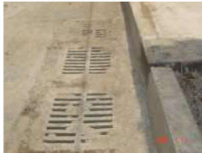
Figura 4.33b. Varias de las inundaciones que ocurren en Santa Isabel Industrial como en muchas otras colonias de Iztapalapa, se deben a la falta de mantenimiento a las alcantarillas.
