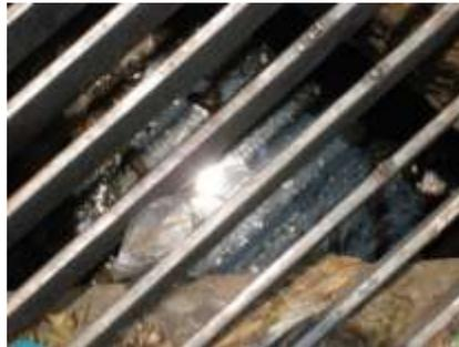
Figura 4.41 f. En la imagen se observa que las alcantarillas ubicadas entre Villa Cid y Villa Franqueza están completamente saturadas de sedimentos.
