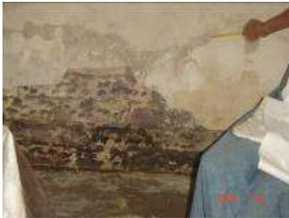
Figura 4.35 a. La vivienda muestra rasgos de humedad debido a dos causas: la inundación como causa directa y la infiltración.
