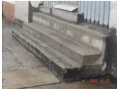
Figura 4.36 b y 4.36 c, respectivamente. En ambas figuras, se observa que en varias de las viviendas han elevado el nivel de las escaleras hasta los 80 cm.
