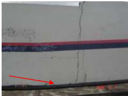
Figura 4.37 a. La flecha indica las mangueras de una bomba, la cual tiene la función de desalojar el agua; sin embargo, llega a afectar a la Calzada Ignacio Zaragoza, pues es allí donde desemboca toda el agua.
