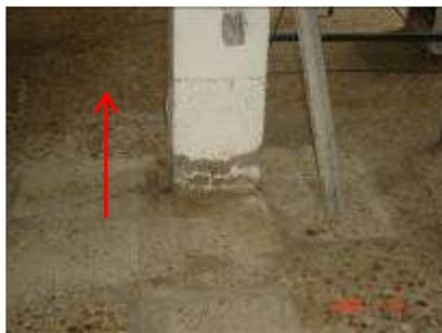
Figura 4.35 c. La inundación del 3 de julio del 2006, dejó en varias de las viviendas de la colonia, la evidencia del tirante que alcanzó 60 cm.
