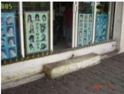
Figura 4.33 a. A lo largo de la Avenida Tláhuac, existen diversos comercios que están protegidos con muros de más de 40 cm para evitar la entrada del agua, ante las intensas lluvias.
