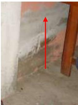
Figura 4.42 c. La flecha indica cerca de 0.50 m de altura, a la que ha llegado el agua dentro de una vivienda ubicada en la Unidad Solidaridad
