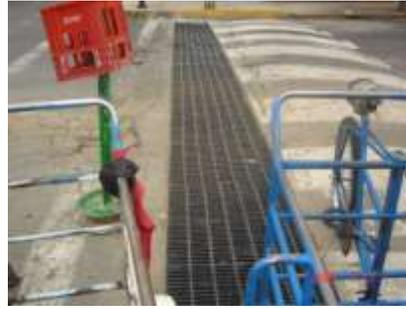
Figura 4.31c. Nueva alcantarilla para evitar las inundaciones en la calle de Agricultores esquina con Trojes. Aunque ha reducido la magnitud de las inundaciones, éstas siguen presentándose.
