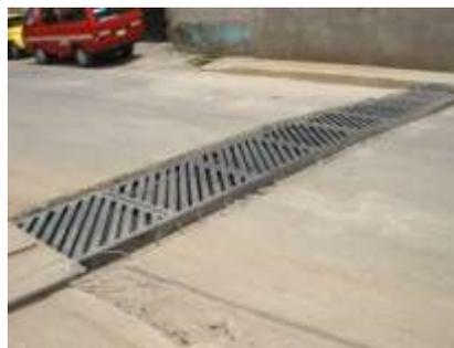
Figura 4.44 e. El organismo encargado, ha colocado una serie de alcantarillas en la mayoría de las calles afectadas.
