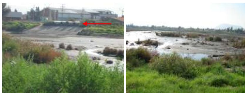
Figuras 4.42 a y 4.42 b respectivamente. En la fotografía se observa la laguna de regulación ubicada a lo largo de la Av. Prol. Octavio Paz; durante un evento de fuerte precipitación, para evitar la saturación del drenaje además de poner a trabajar las plantas de bombeo, conducen las aguas hacia la laguna.
