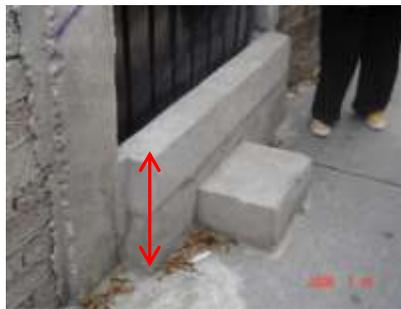
Figura 4.34 b. La flecha indica un muro de 50 cm aproximadamente que se colocó para evitar la entrada del agua ante una inundación, sin embargo el 1° de julio del 2006 rebasó este muro.
