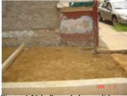
Figura 4.31 b. Parte de las medidas para que los transeúntes puedan caminar ante una inundación menor a 30 cm de altura es el aumento del nivel de las banquetas.
