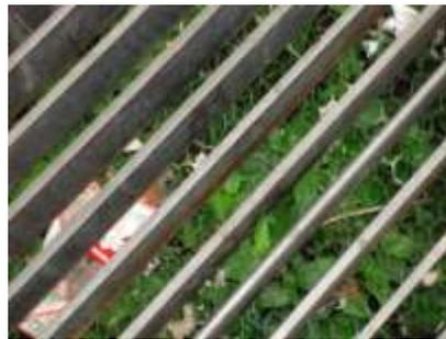
Figuras 4.39 b y 4.39 c, respectivamente. Nuevas alcantarillas ubicadas en las cercanías del cerro de la Estrella, cuya dimensión es de largo igual al ancho de la calle; sin embargo, a pesar de ser recientes todas muestran falta de mantenimiento.
