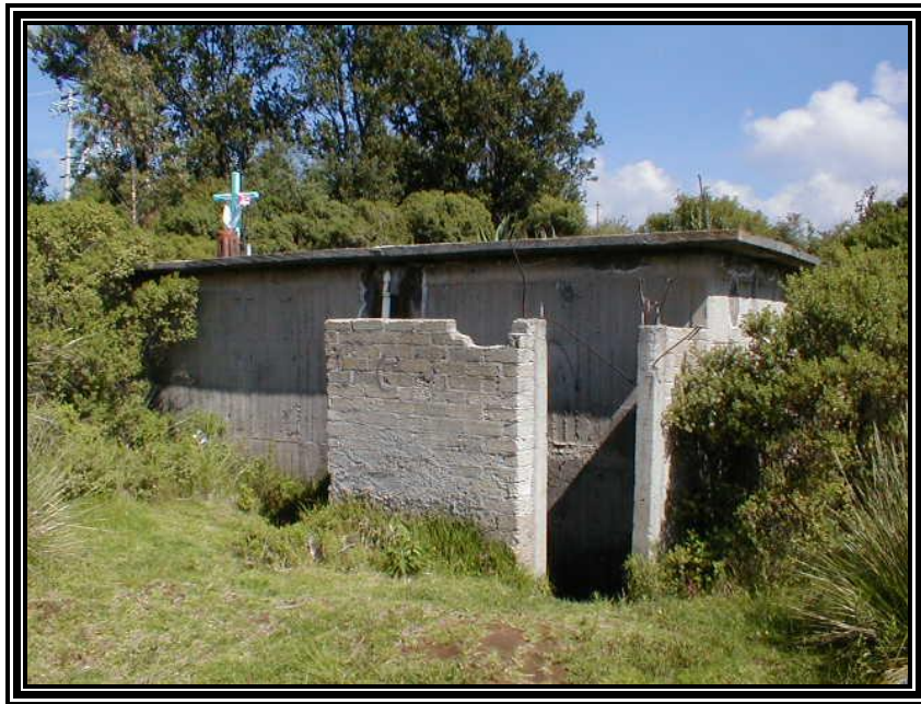
Figura 4.5 tanque de almacenamiento existente.
