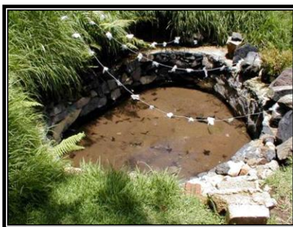
Figura 2.18 fuente de abastecimiento “Paraje Puendo”
