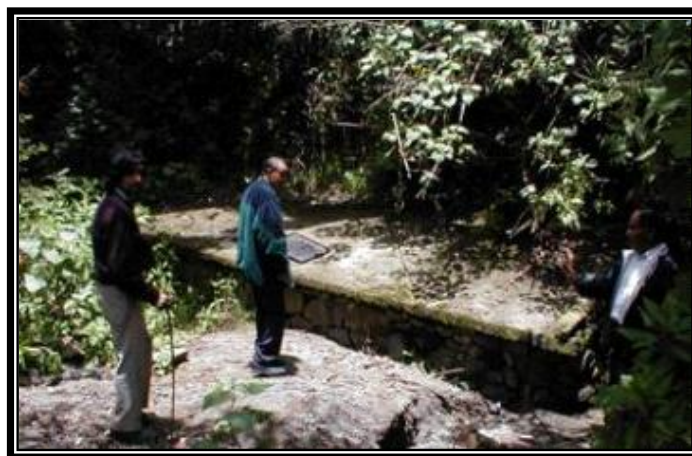
Figura 2.17 fuente de abastecimiento “El Quinte”
