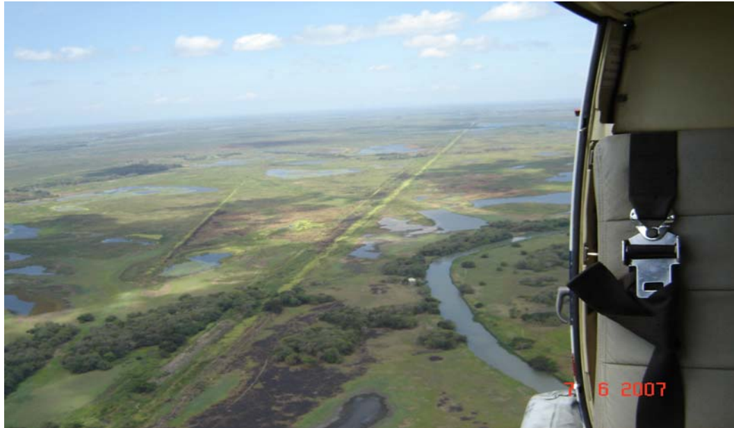
Figura 4.10 Toma aérea del ducto que se recorrido.
