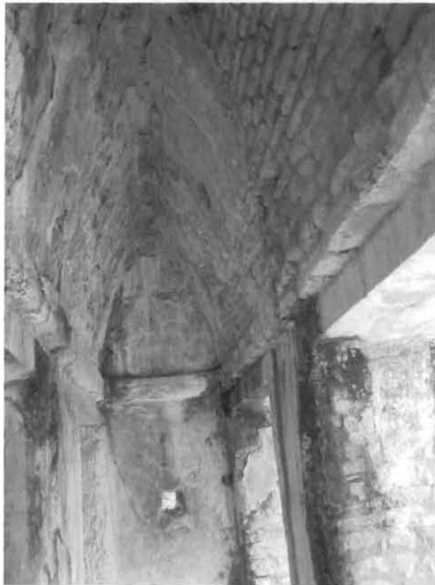
Figura 20. Templo del conde. Crujía frontal del edificio, ambos se muestran muy similares en cuanto a tamaño, distribución de espacios y estilo arquitectónico, por lo que se les ubica para la misma época.
