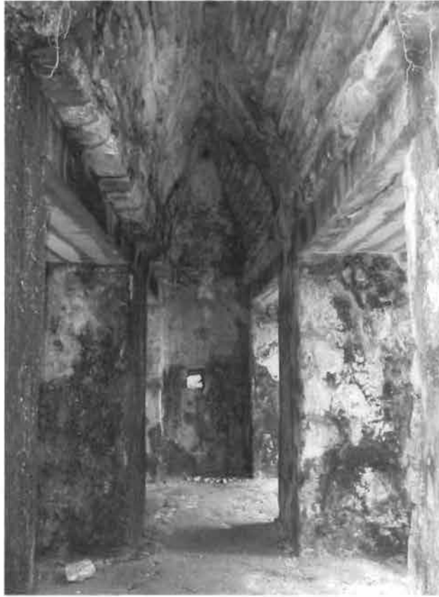
Figura 19. Templo Olvidado. Crujía frontal del edificio.
