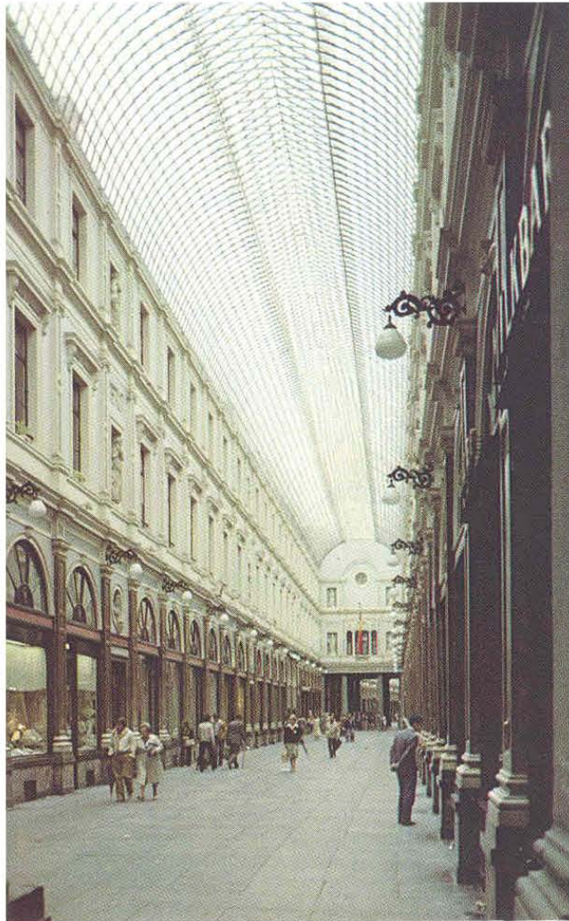
Galerías St. Hubert, Bruselas, obra de J.P. Cluysenaar (1839-46)
