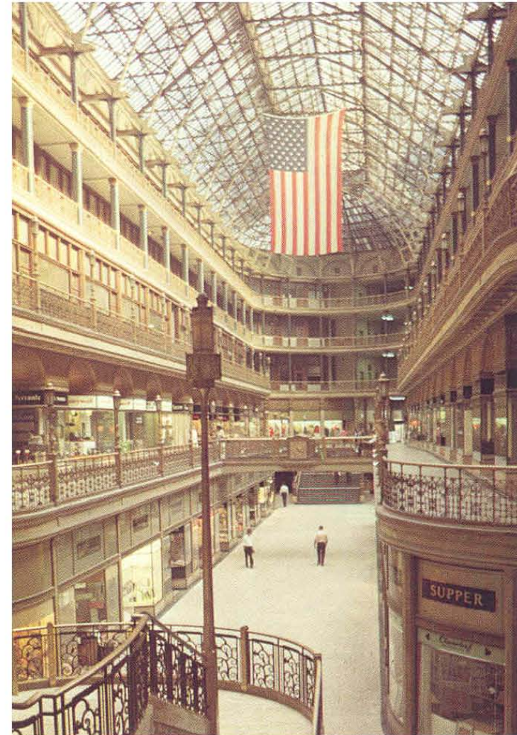
The Old Arcade, Cleveland, Ohio, obra de Eisenmann y Smith (1890). El cristal y el hierro se introdujeron también como cubierta en las nuevas arcadas de tiendas.
