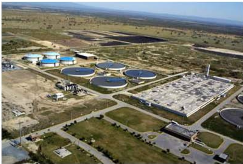
Figura 14. Planta de tratamiento de aguas residuales
