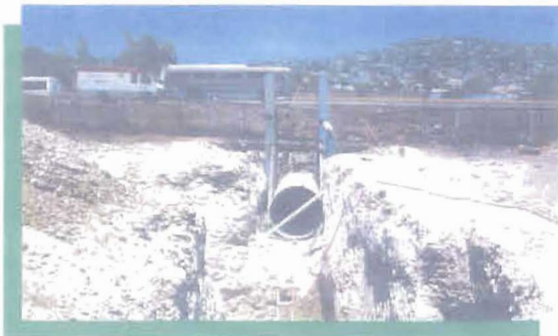
Cruce del acueducto por abajo de la autopista México-Pochitlán.
