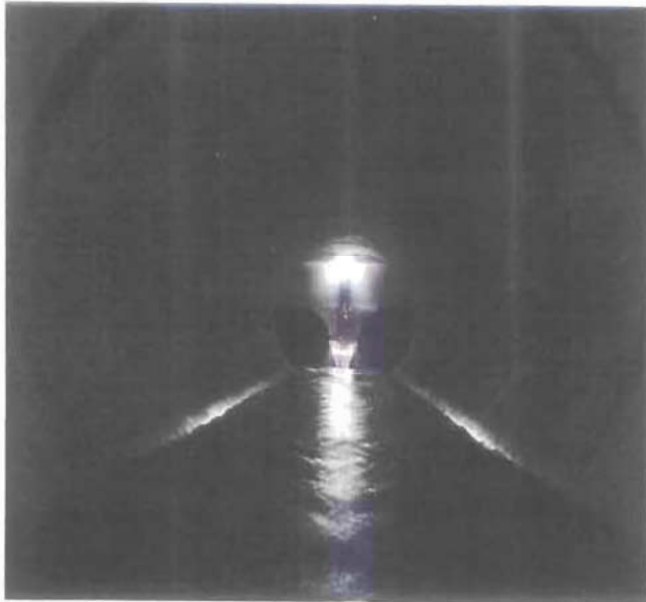
Túnel en operación
