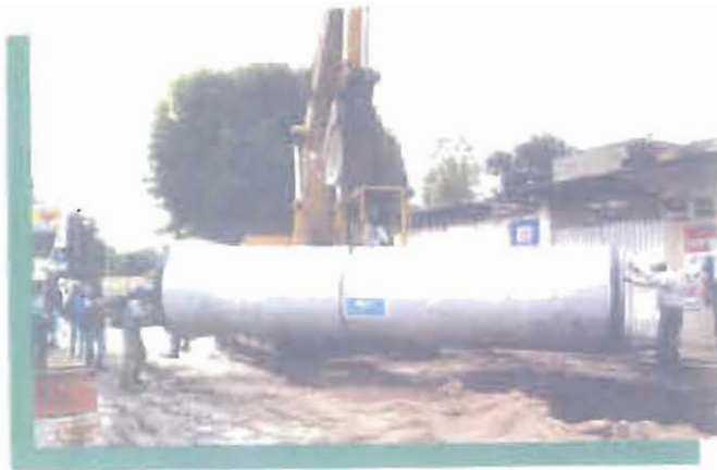
Se colocó tubería prefabricada de alta resistencia.
