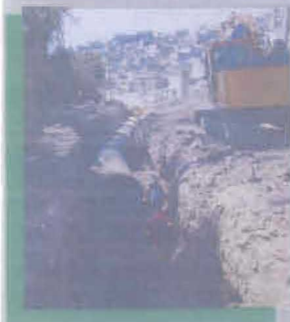
Tendido de tubería de concreto reforzado
