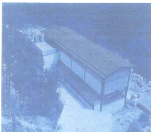
Planta de bombeo No. 6
