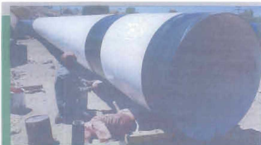
Trabajos de protección anticorrosiva de tubería de acero
