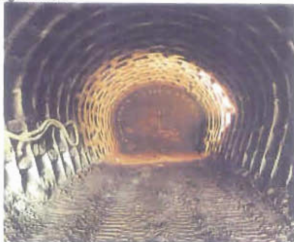
Barrenos en el frente de excavación
