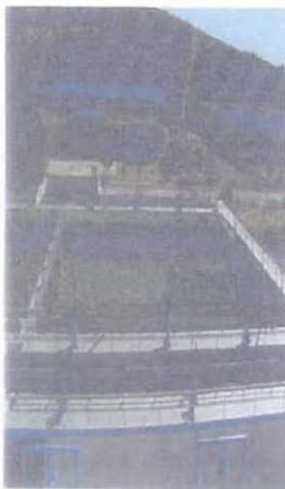
Tanque de agua cruda
