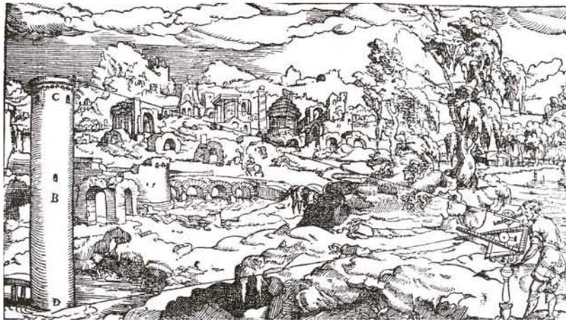
Abel Foullon, *Usage et description de l'holometre* (1555), Medición de la altura de una torre con un holómetro, en Navarro de Z., J., 1996, p. 495.
