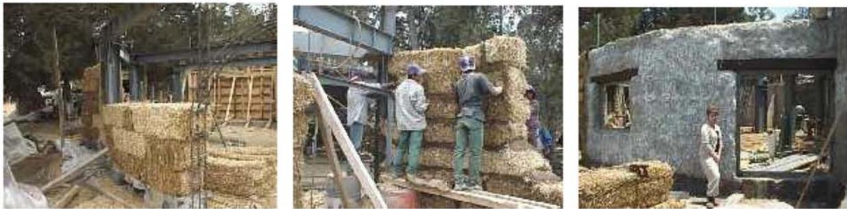
Fotografías que muestran la construcción de muros con paja
