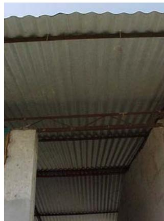
Cubierta de lámina de zinc apoyada en estructura metálica. En esta región del estado se registran temperaturas de arriba de 40 grados centígrados
