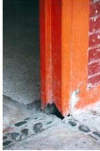
Detalle de monten de apoyo desgastado por efecto de la humedad.
