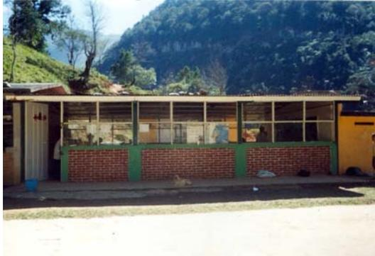
En días lluviosos el agua penetra por las ventanas, debido a lo corto de los aleros, además que se filtra por la cubierta.
