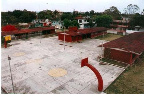
Debido a lo deteriorado de la estructura fue necesario demoler los dos cuerpos de edificios (de derecha a izquierda). Fueron construidos con elementos prefabricados en estructura portante a base de vigas metálicas, con muros divisorios de tabique y losa de concreto de 10 cms.
