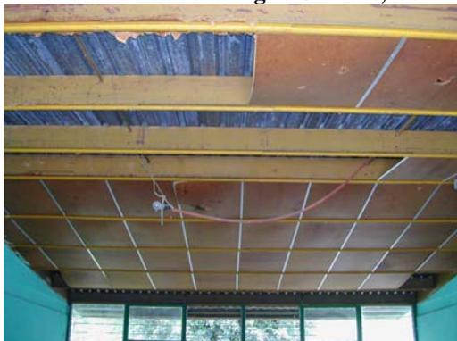
Sistema constructivo de cubierta a base de lámina de zinc apoyada en vigas de madera y con plafón de fibracel. Se observan las instalaciones expuestas.
