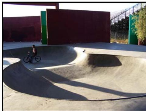
**Ilustración 6.11** *Bowl* en forma de 8, de aproximadamente 1 metro de profundidad, construido en concreto y con coping tubería cilíndrica de metal. Foto tomada oct. 2007 por el autor.
