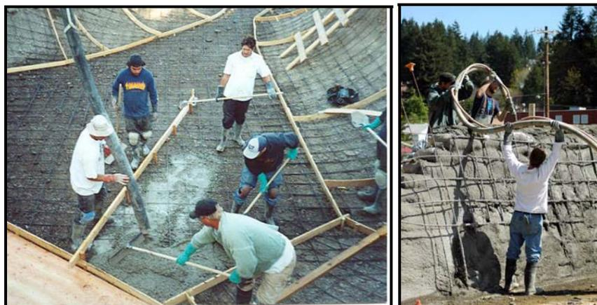
**Ilustración 7.3** Proceso de vaciado de concreto dentro de separadores y moldes **(a)**. Para paramentos y *transiciones* es necesario formar estibas trabajando el material desde abajo hacia arriba **(b)**. Fotos tomadas de: <http://www.airspeedskateparks.com/constructionguidelines.php>.
