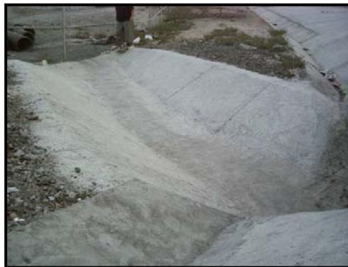
**Ilustración 5.1** Transición angular entre piso y paramento, típico de zanjas de drenaje. Foto tomada oct. 2005 por el autor.
