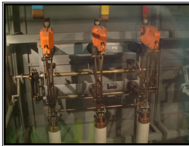
Fig 2.14 Sección de alimentadores con sus respectivos fusibles.
