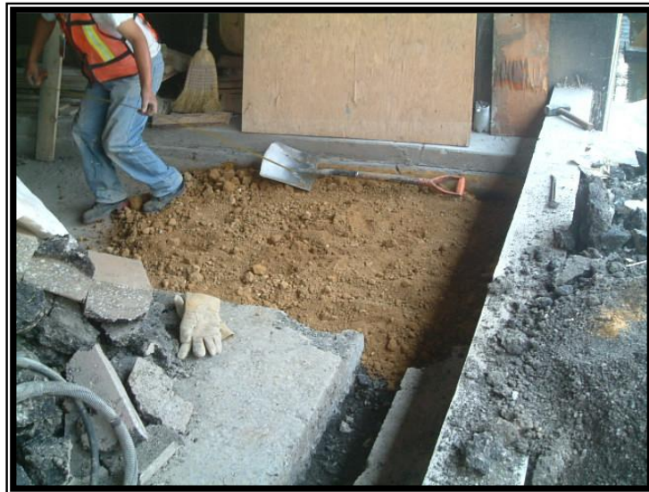
Figura 3.1 Muestra parte de los trabajos de demolición en la obra civil.
