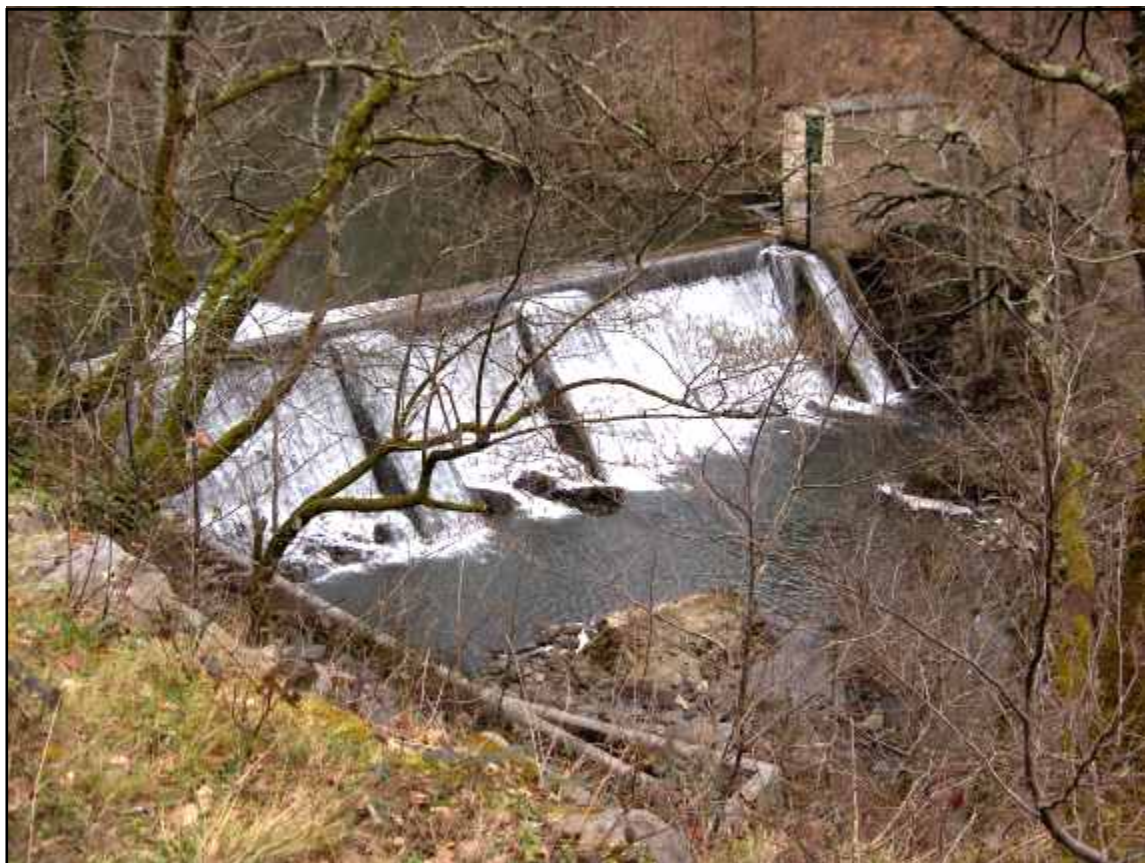
Figura No. III.1. Obra de toma.
