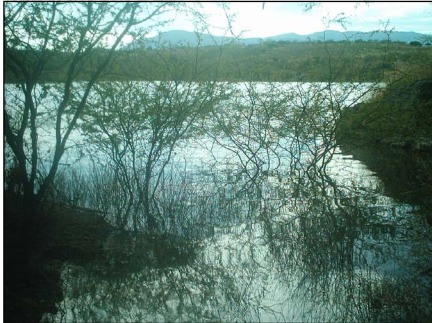
Figura No. II.8.Vaso de la presa Achoquen en la descarga.
