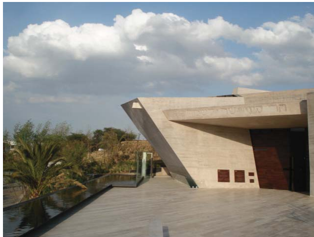
Fachada Oriente; observamos el acceso principal. (10-04-07)
