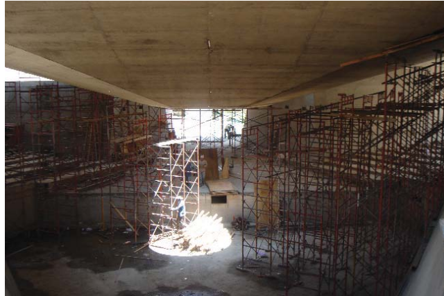
Sistema de cimbra durante el proceso de colado de la losa interior del templo. (11-07-06)
