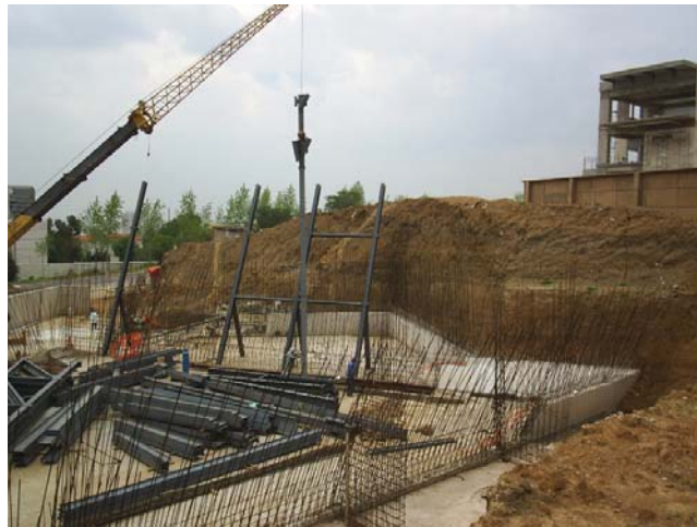
Colocación de las primeras columnas metálicas ancladas a placas base previamente coladas in situ durante los trabajos de cimentación. (15-06-05)
