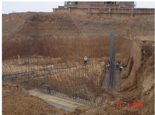
Armado de zapatas de cimentación donde iniciará el desplante de los muros principales del Templo. (21-04-05)
