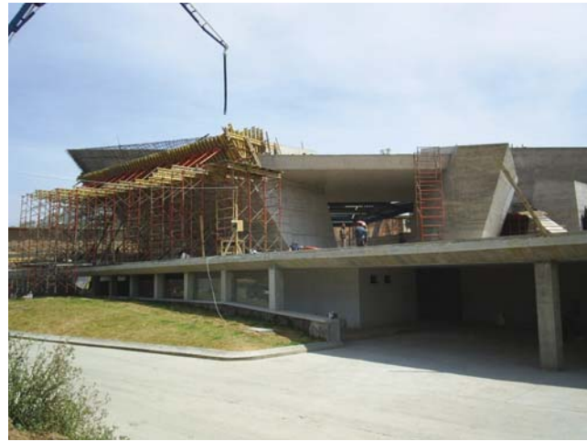
Vista general desde el acceso vehicular. Observamos la última fase de colado del muro principal del templo. (10-03-06)
