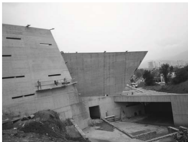
Vista desde los jardines. Observamos la torre del Mi-drash aún en proceso constructivo. (11-07-06)
