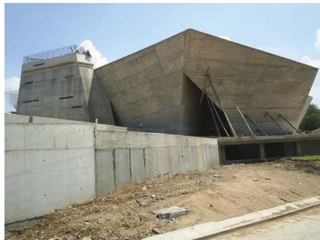
Vista general desde la calle de acceso. Observamos el e Midrash (torre del lado izquierdo) por concluirse. (27-04-06)
