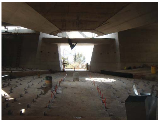
Vista interior del templo desde la parte posterior hacia la entrada principal. En ésta etapa ya se ha terminado de colar por completo todos los muros de concreto del templo y la losa. Se comenzarán con los trabajos de acabados . (11-09-06)
