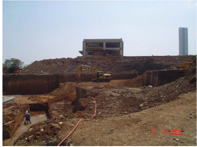
Vista del terreno durante los trabajos previos de excavación y movimiento de tierras. (05-04-05)
