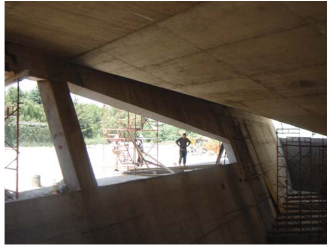
Vista interior del templo. Los colados interiores del plafon se encuentran en la etapa final. (27-07-06)
