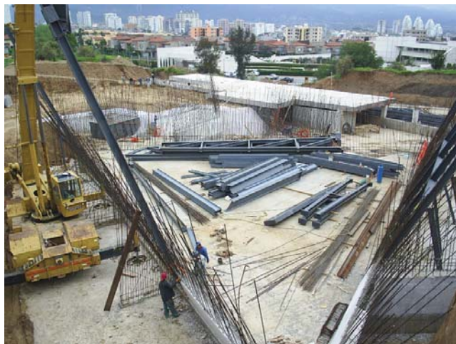
Vista superior del templo donde observamos la estructura metálica. (15-07-05)
