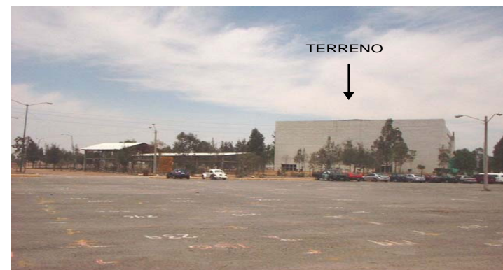
VISTA PONIENTE DESDE EL ESTACIONAMIENTO
