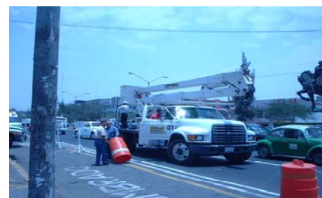
Trabajos de mantenimiento por parte del municipio
