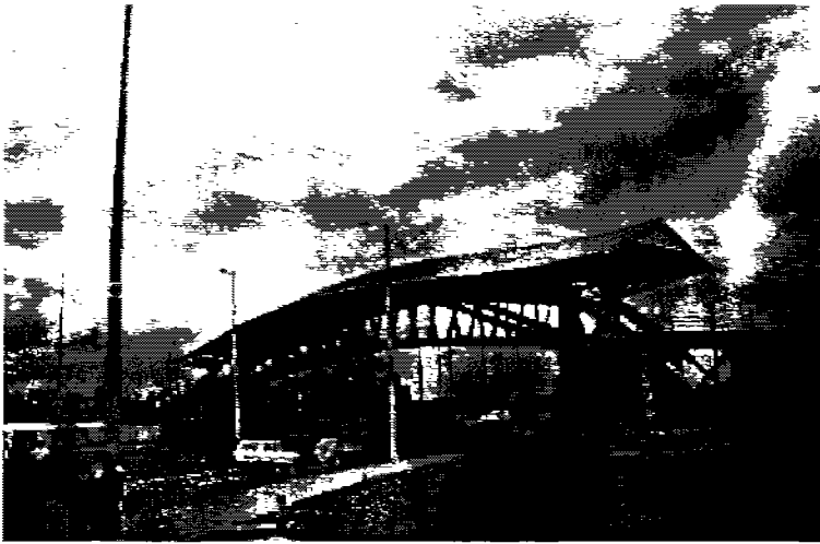
Puente peatonal cubierto, 45 m luz. Bogotá, Colombia Estructura de caña guadua y bambú Arq. Simón Vélez
