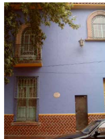
83. Basamento de ladrillo.
