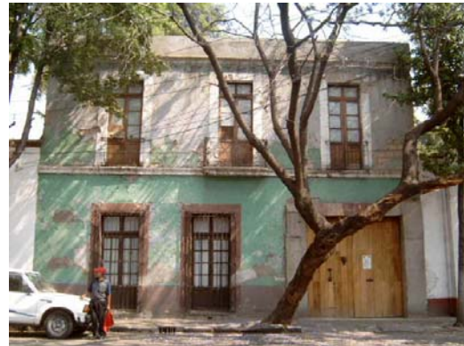
81. Basamento de concreto aparente.
