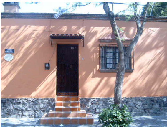
79. Basamento de piedra
