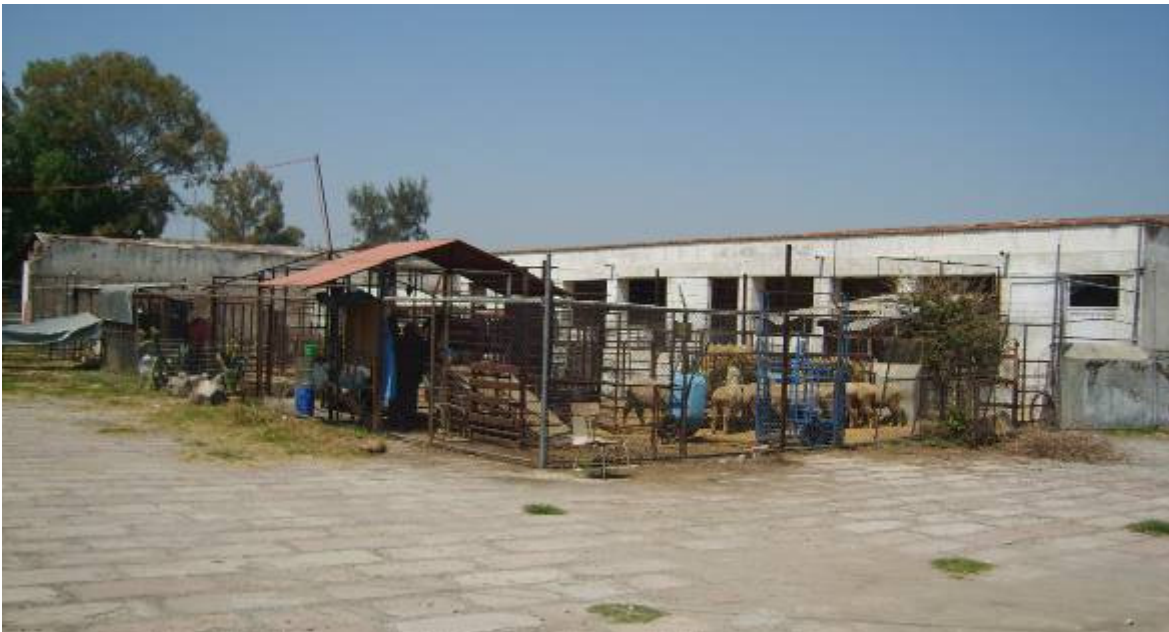
Figura 1. Instalaciones del módulo ovino y caprino
