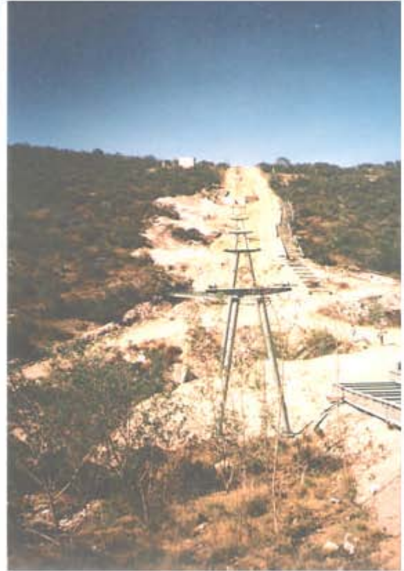
En estas fotografías se observa el montaje de tramo elevado sobre estructura y es estas últimas lo que es tramos en el piso
