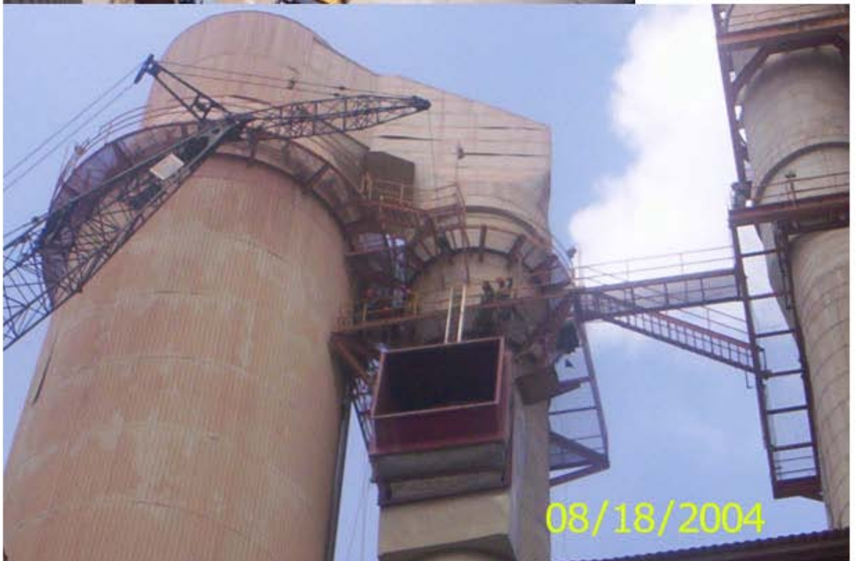
Algunos ejemplos de los trabajos durante el montaje del molino y sus conexiones con la planta actual.
