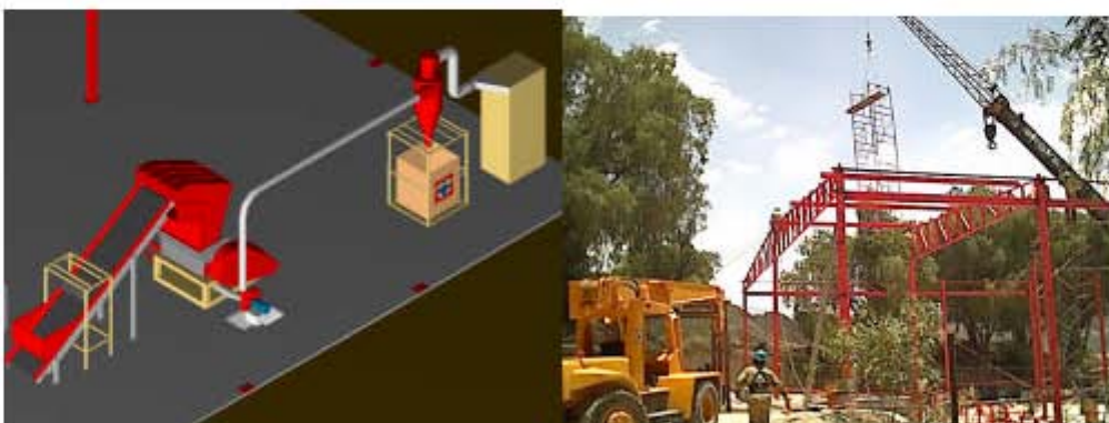
Diseño del triturador y foto de la instalación de la estructura donde se alojará el Tritrador.
