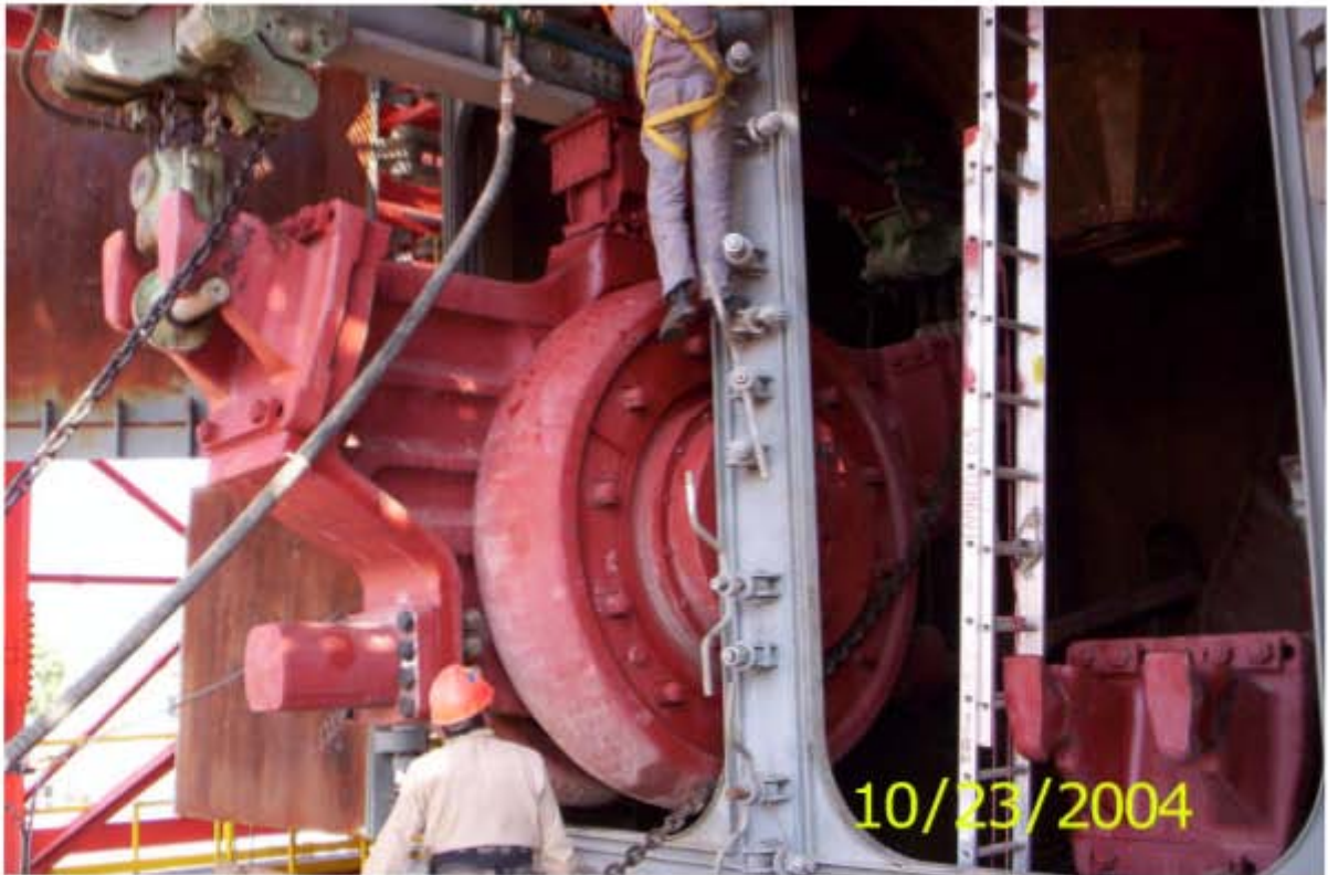
Detalle de los roles de molienda al ser introducidos al interior de la carcaza del molino
