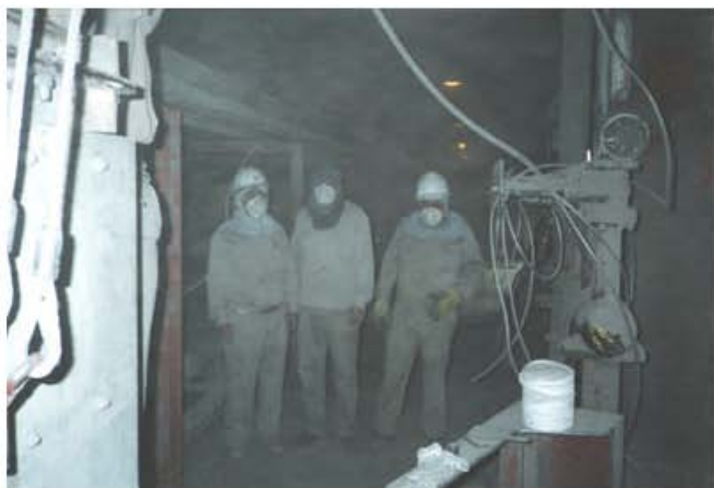
UN DIA DE TRABAJO EN LA INSTALACIÓN DEL TRANSPORTE DE CLINKER
