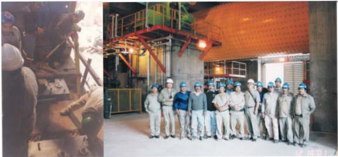
Detalle de instalación de la base del reductor principal del molino y el grupo de trabajo el día de inauguración de las instalaciones
