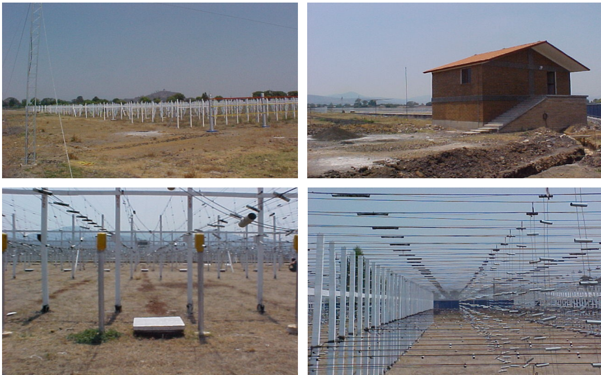
Figura 3.2 Siguiendo el orden de izquierda a derecha a) las dimensiones físicas de la antena o plataforma principal, b) el cuarto de control donde se encuentran los instrumentos receptores, graficadores y fuentes de poder, c) el sistema subterráneo de amplificación que conduce la señal, d) postes que soportan gran parte el peso de la estructura de la antena.
