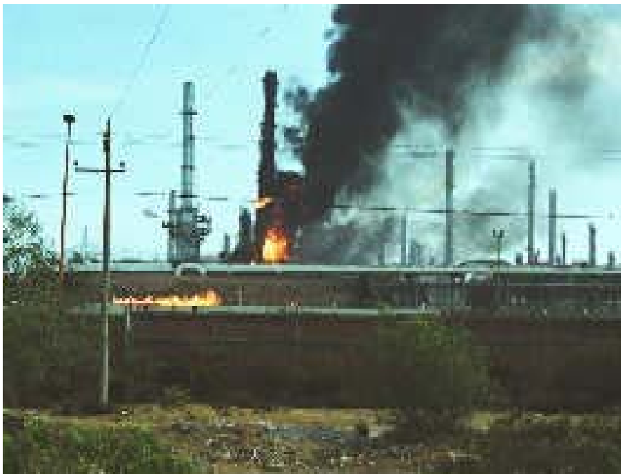
Figura 7. Incendio en la refinería “Miguel Hidalgo” de Pemex, Tula HGO. Fuente: PROFEPA 2002
