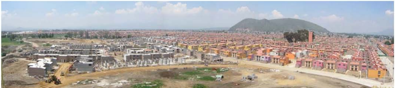
VISTA PANORÁMICA DE CONJUNTO HABITACIONAL LAS PALMAS
