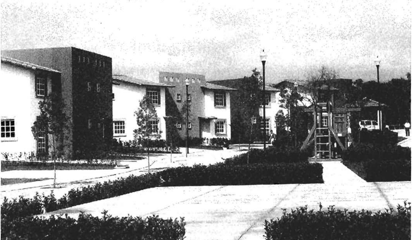
CLAUSTRO AGOSTO 2007 (IMAGEN LATERAL DESDE ÁREA COMÚN)
