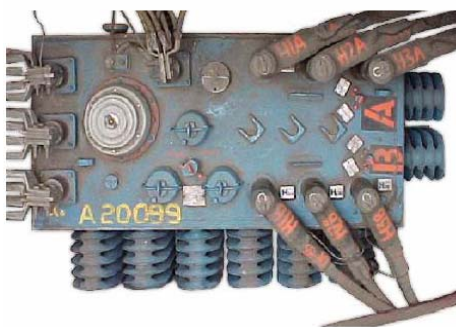
FIGURA 4. TRANSFORMADOR TRIFÁSICO TIPO SUMERGIBLE PARA DISTRIBUCIÓN COMERCIAL
