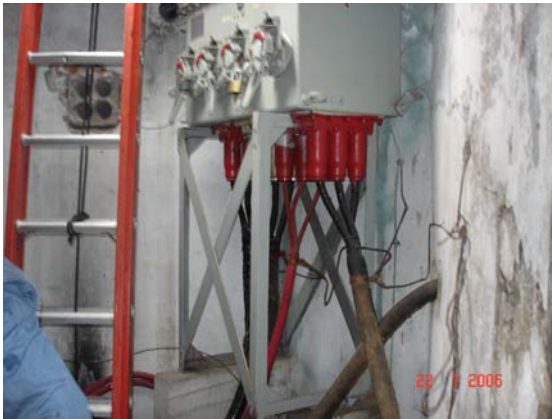
Figura 49. SECCIONADOR EN ACEITE
