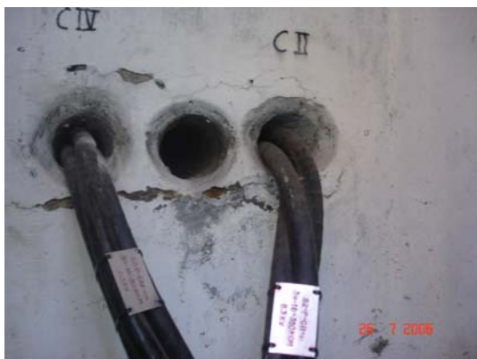
Figura 52. BANCO DE DUCTOS
