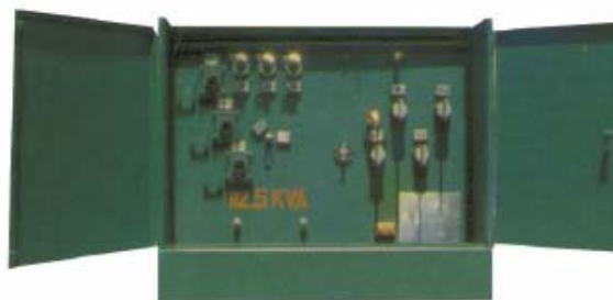
FIGURA 5. TRANSFORMADOR TRIFÁSICO TIPO PEDESTAL PARA DISTRIBUCIÓN RESIDENCIAL
