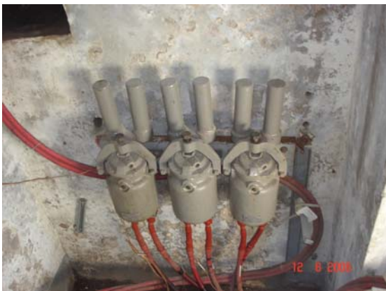
Figura 50. CORTACIRCUITOS EN ACEITE
