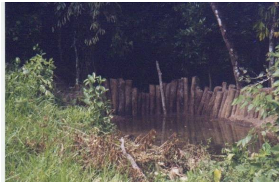
foto 35 y 36 construcción de la represa rustica para la toma de agua
