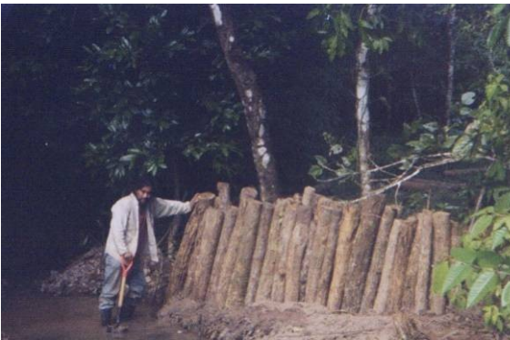
foto 35 y 36 construcción de la represa rustica para la toma de agua
