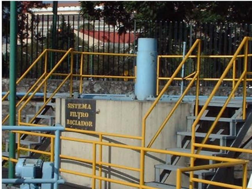
Fig. 6 Sistema de filtro rociador (percolador) de la PTARCU.
