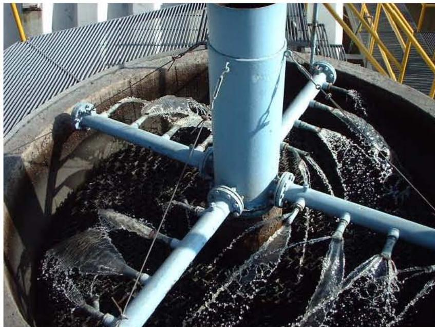
Fig. 7 Sistema de rocío del filtro percolador.
