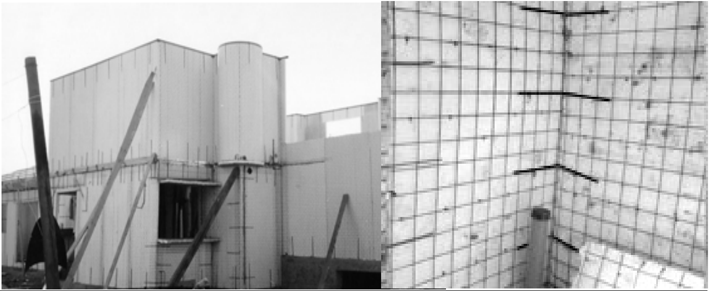
Figura 32. Construcciones con muros de poliestireno expandido o muros Covintec
