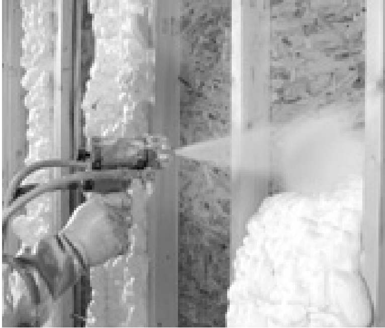
Figura 34. Aplicación de poliuretano esreado en muros.
