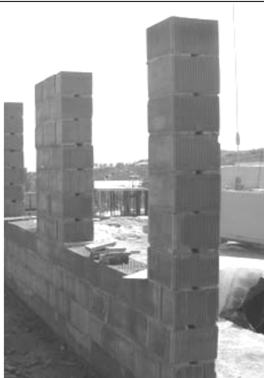
Figura 37. Mampostería con continuidad entre cámaras de aire
