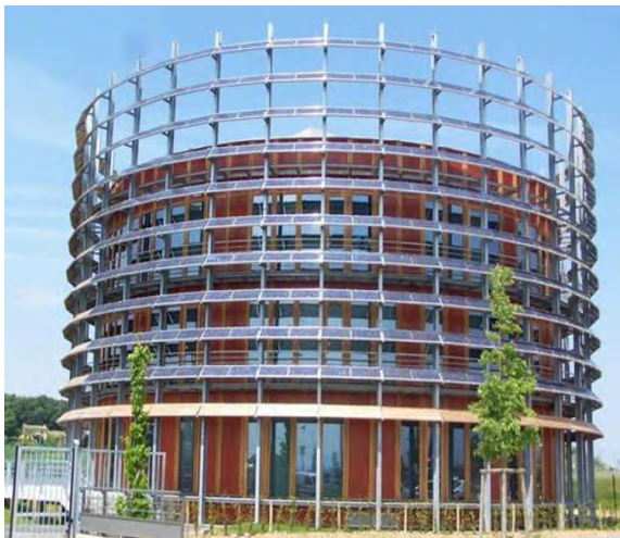
Módulos con marco independiente del tejado.
