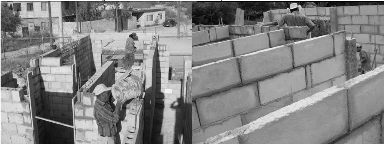
Figura 36. Construcción de vivienda con bloques de concreto celular
