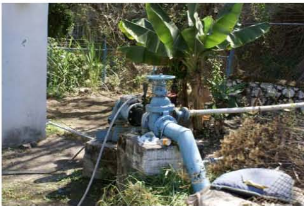
Fotografía 3. Pozo La Presa
