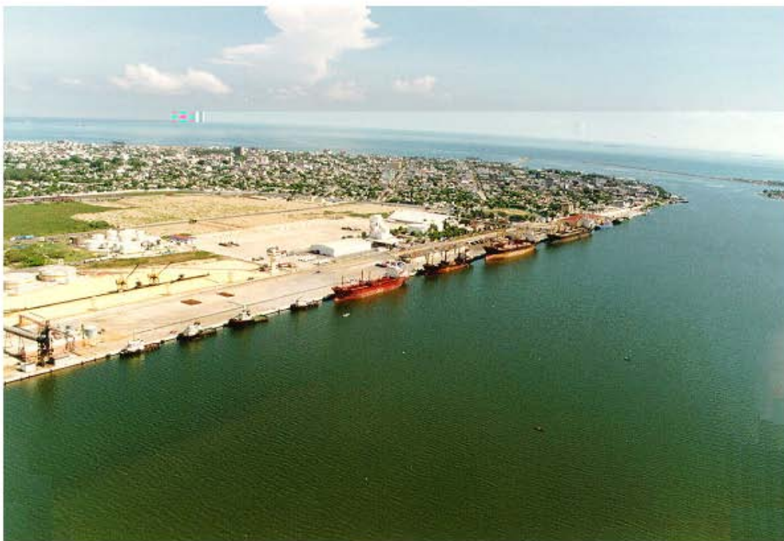
Figura 1. API Coatzacoalcos. Vista de terminales No. 1.
