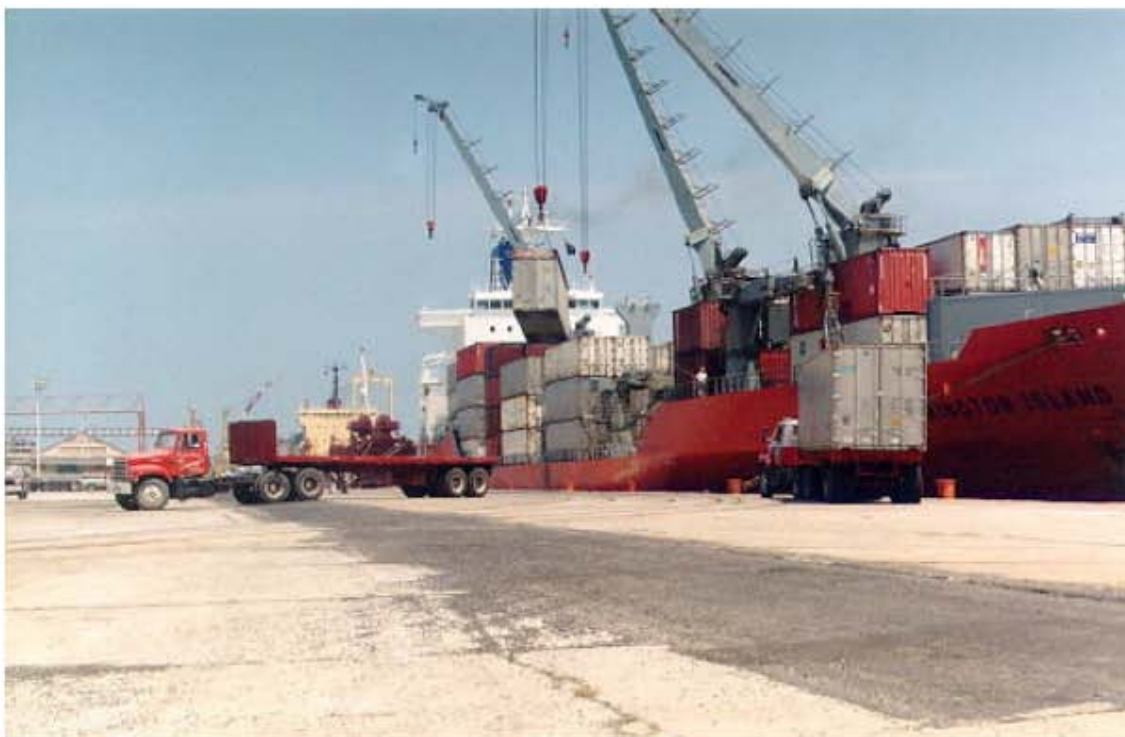
Figura 2. API Coatzacoalcos. Vista de terminales No. 3.
