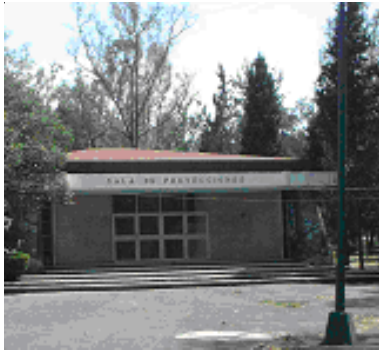
Fig. 23. Vista a la sala de proyecciones.
