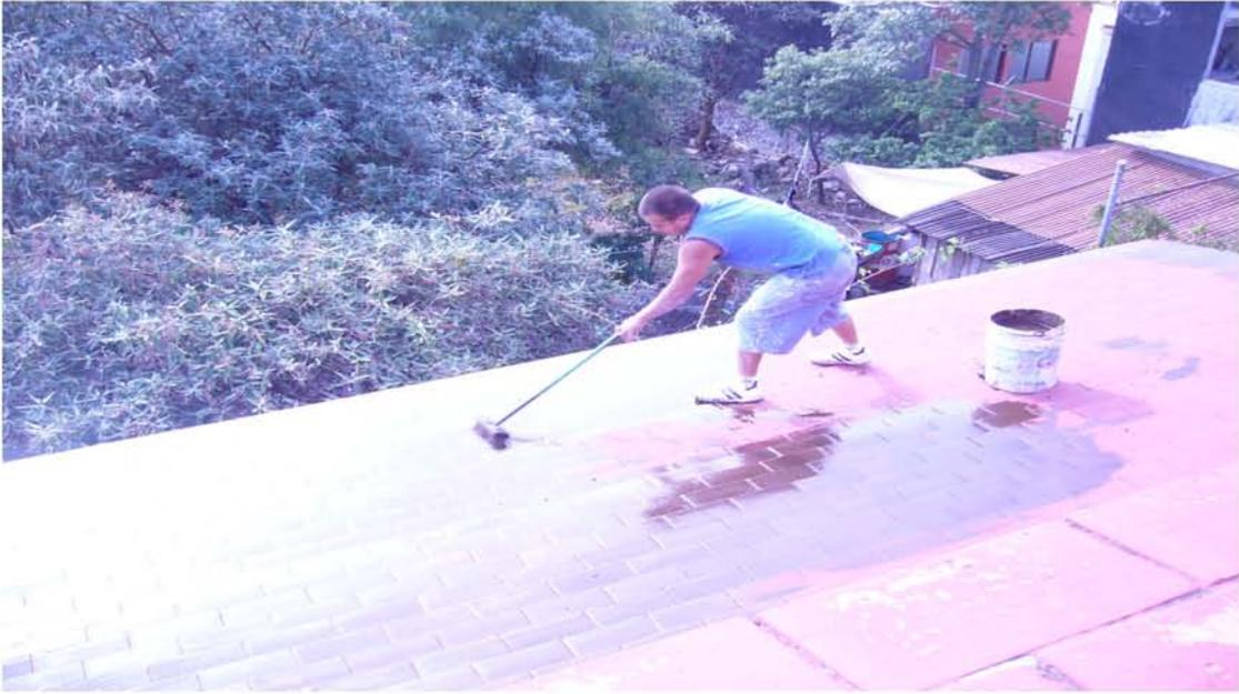
El segundo paso consistió en poner la pasta asbética base agua, para poder colocar el impermeabilizante en tela a3p.
