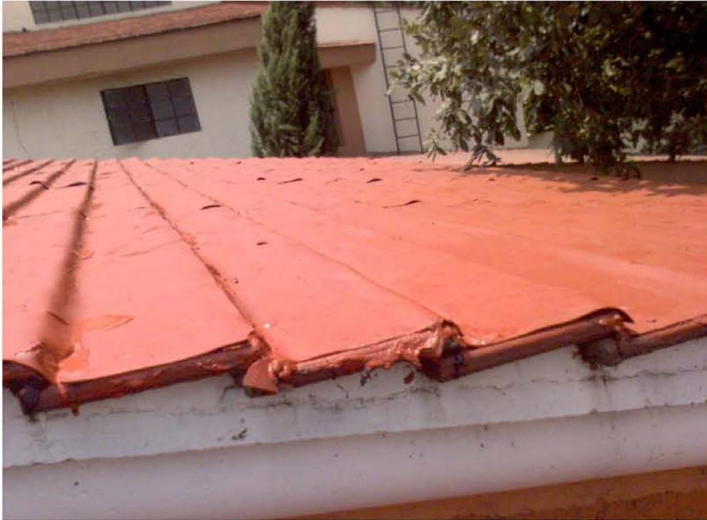
Después de haber terminado de impermeabilizar el techo, se continuó con la impermeabilización del muro, en este caso el proceso se realizó únicamente con la pasta asbésica base solvente mezclada con polvo de llanta y se procedió a colocar en la pared.
