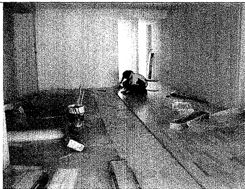
14. COLOCACIÓN DE PISO MADERA.
