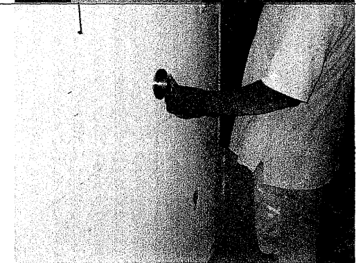
16. TRAZO Y COLOCACIÓN DE LLAVES.
