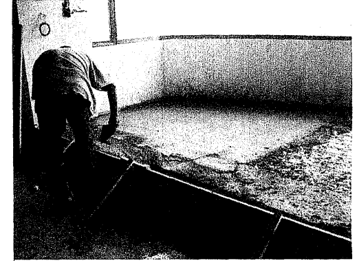
7. COLADO DE FIRMES.
