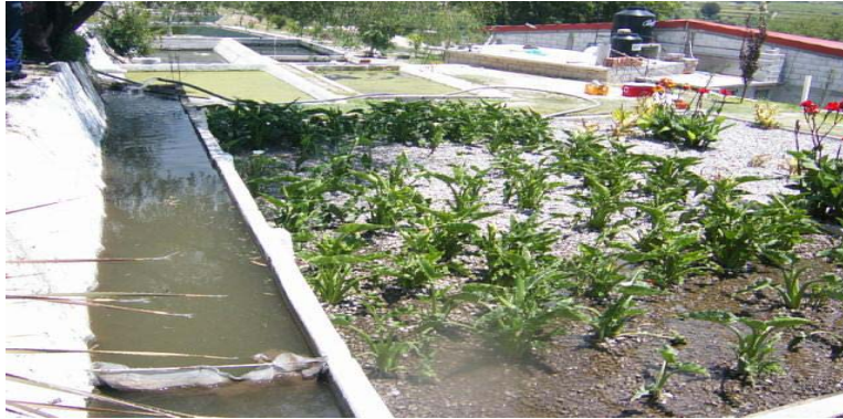
Figura 9. Alcatraces del humedal construido en Julián Villagrán, Hidalgo (2005).
