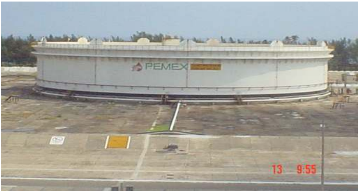
Figura 1.6 Tanque de almacenamiento de techo flotante.
