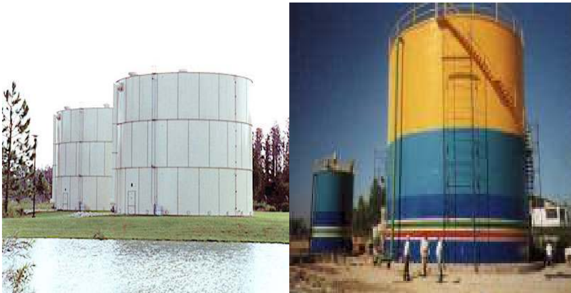
Figura 1.1 Tanque de almacenamiento de techo fijo.
