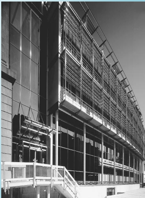
Figura 5.4: Biel, Suiza. Esta imagen muestra como la estructura enfrente del muro de cristal, se encuentra sostenida por unos postes que liberan la planta baja de paneles prismáticos móviles. Por detrás de esos paneles, se ubican paneles prismáticos redireccionadores de luz.
