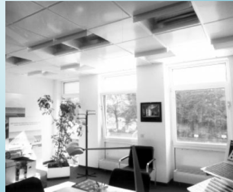
Figura 9.1: Cristal redirector de luz en la parte superior adosado a un cristal común y corriente en el edificio de oficinas de ADO. Coloane. Alemania
