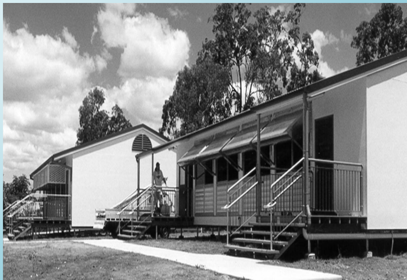
Figura 8.4: Persiana guiadora de luz en un edificio de la escuela E-statal de Parks Regent, Brisbane, Australia
