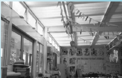
Figura 6.8: Ventanas elaboradas con paneles con corte laser pegadas a la techumbre de un salón de clases
