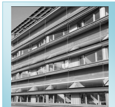
Figura 12.4: Edificio experimental solar LESO, Lausanne, Suiza.
