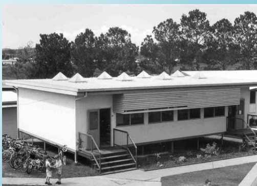
Figura 7.5: Tragaluz Angular selectivo instalado en un salón de clases de la escuela estatal de Waterford, Brisbane, Australia
