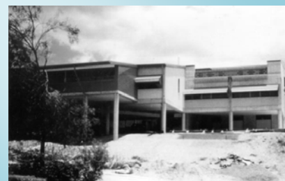
Figura 8.1: Persiana guidora de luz montada en las ventanas norte del herbario ubicado en Brisbane, Australia
