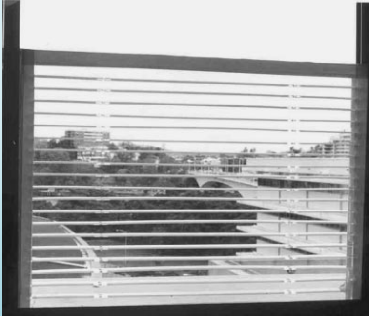
Figura 6.4. Paneles cortados por laser con un ancho de 200 mm pueden ser instalados en una ventana con doble panel de cristal. Los paneles de la ventana en un ángulo correcto, rechazan una alta cantidad incidente de rayos solares mientras que al mismo tiempo mantiene una buena vista.
